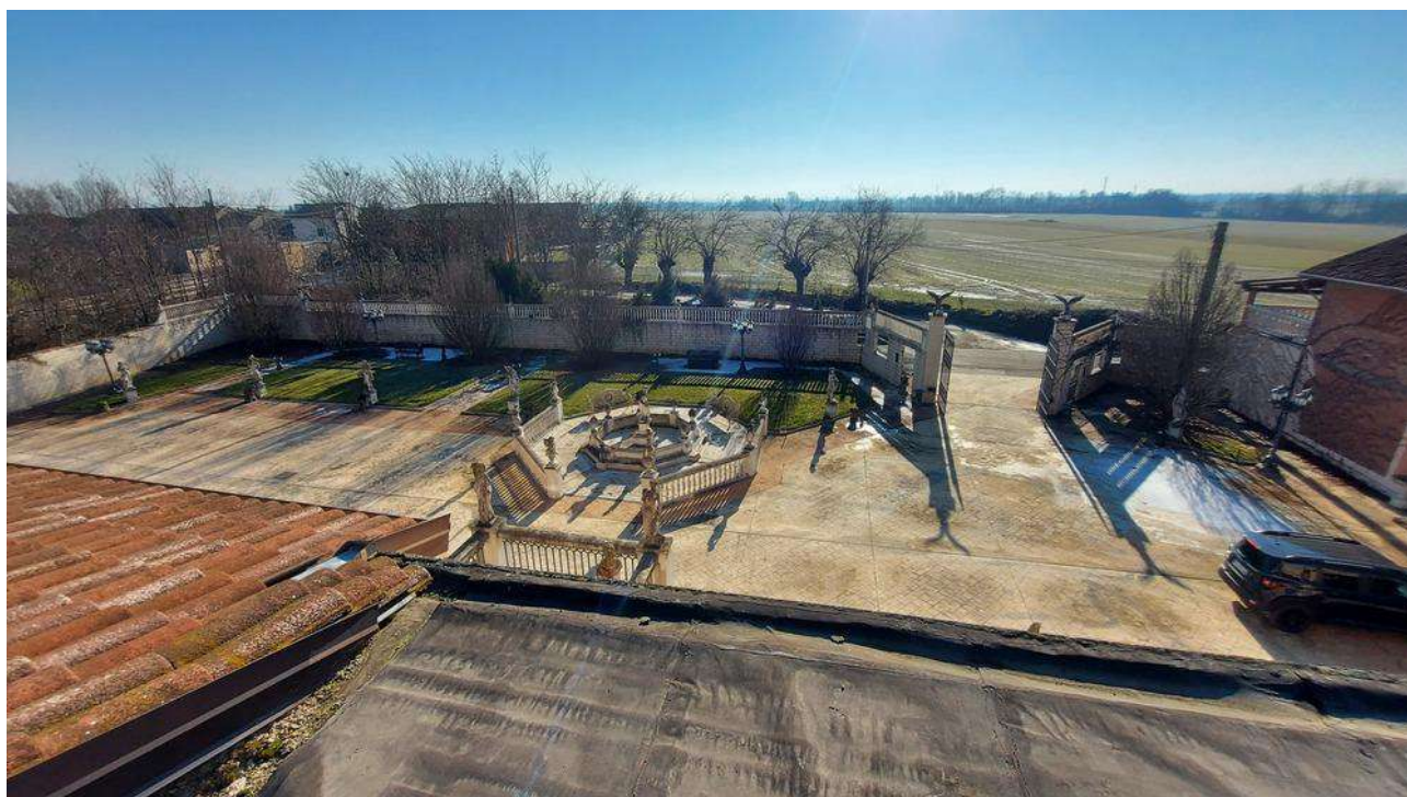
Foto 4 – Vista della corte di ingresso dalla copertura
