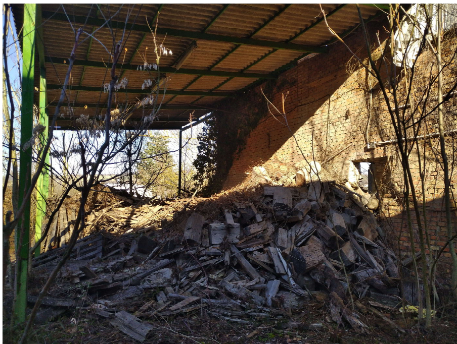
Tettoia adiacente alla fornace da demolire
