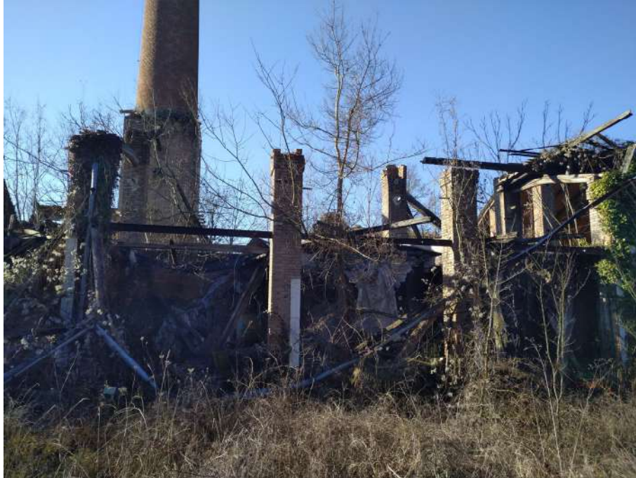
Particolare di alcuni pilastri da mantenere
