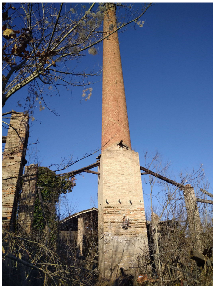
Particolare della ciminiera e di alcuni pilastri da mantenere
