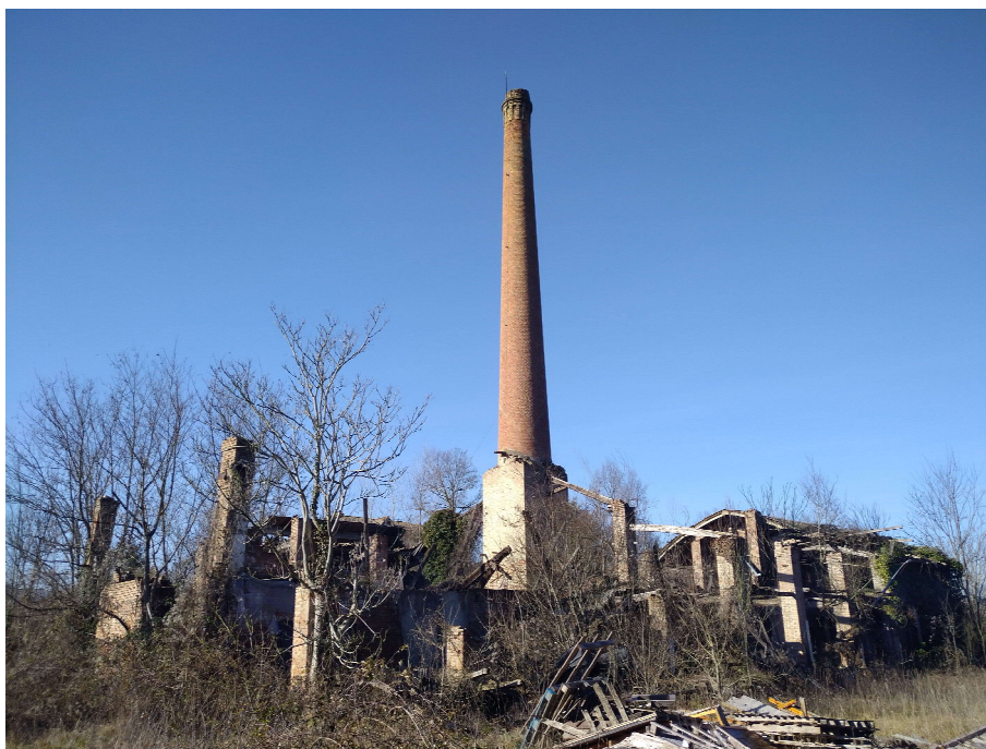
Vista del fabbricato collabente
