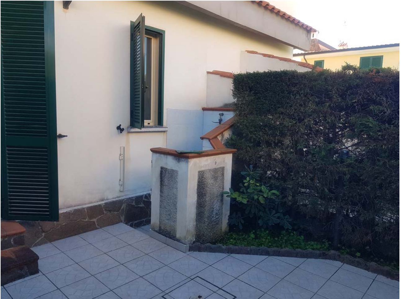
FOTO 24 esterno corte immobile
