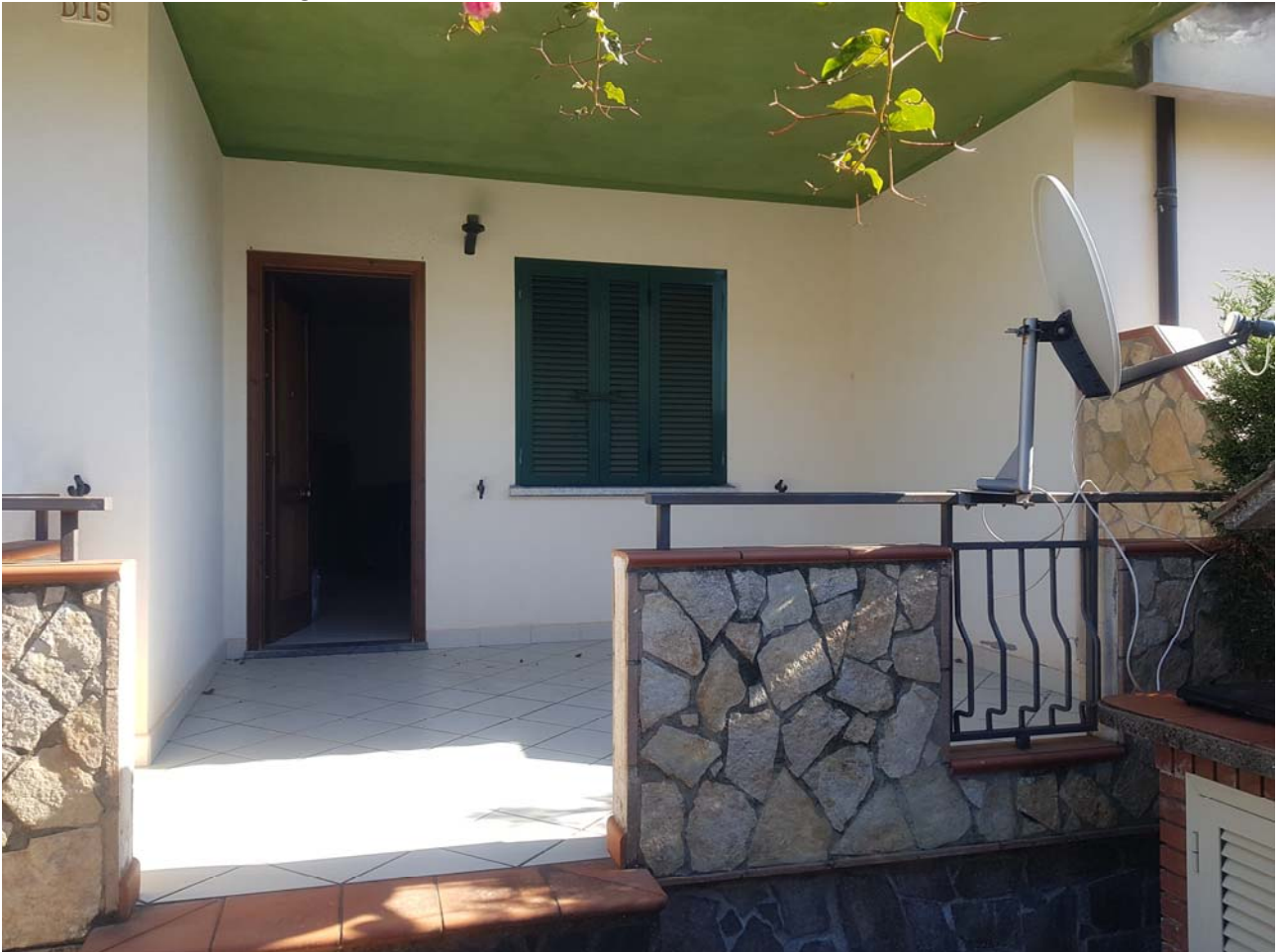
FOTO 06 esterno corte ingresso immobile
