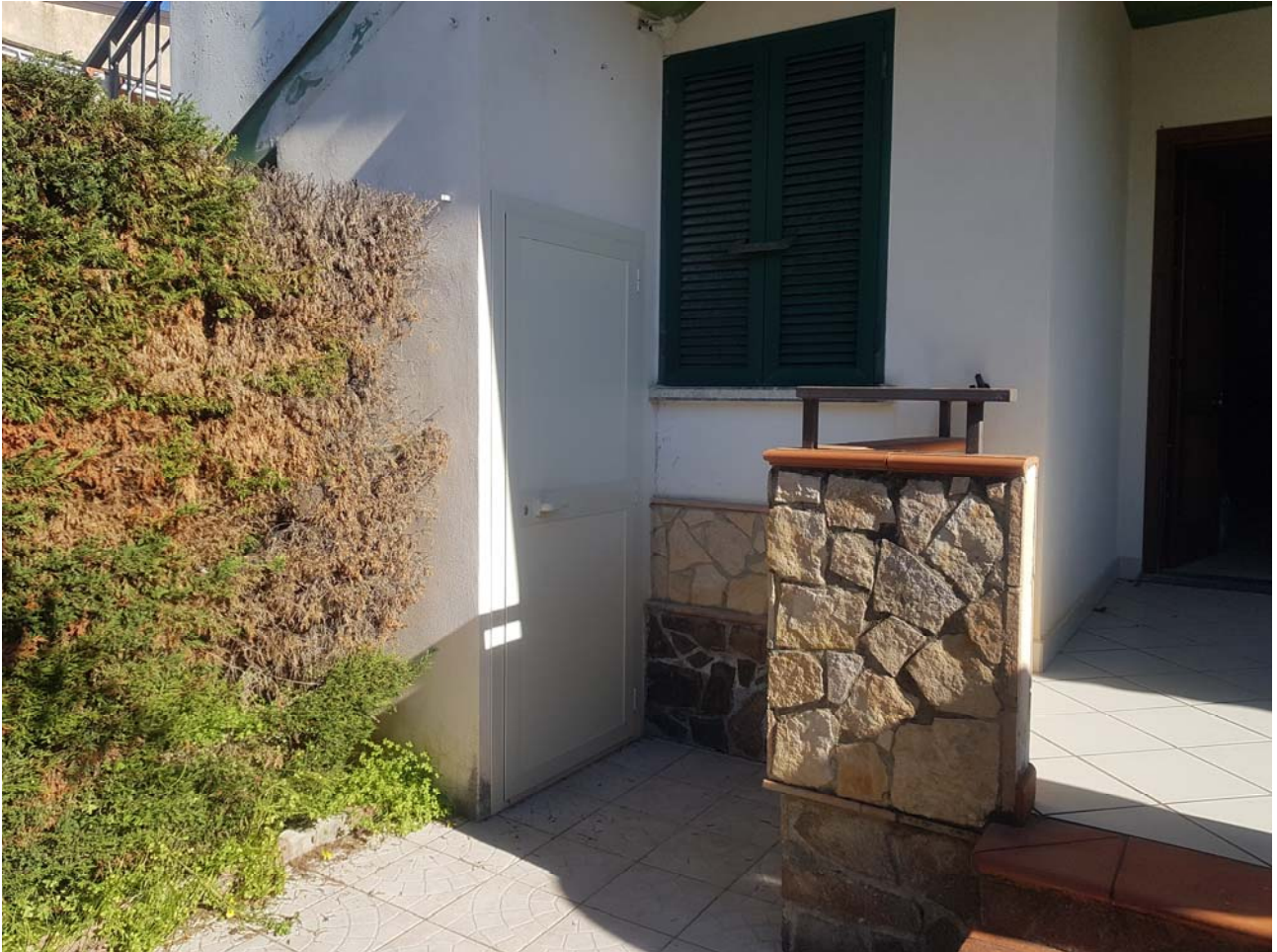
FOTO 05 esterno corte ingresso immobile
