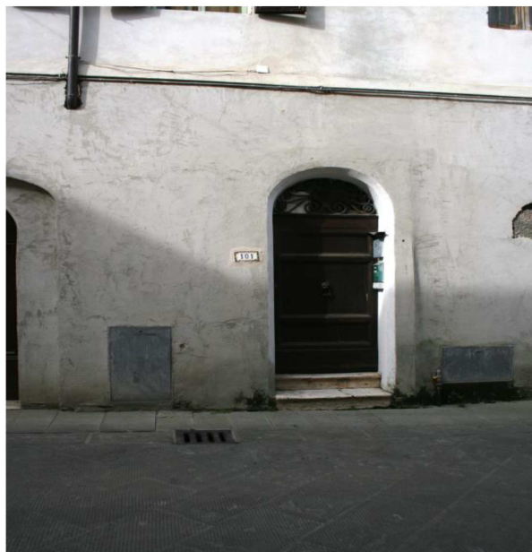
Portone ingresso del palazzo Corso Matteotti
