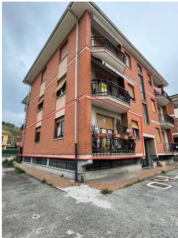
Fotografia A.4 - Esterno stabile su Via Torino
