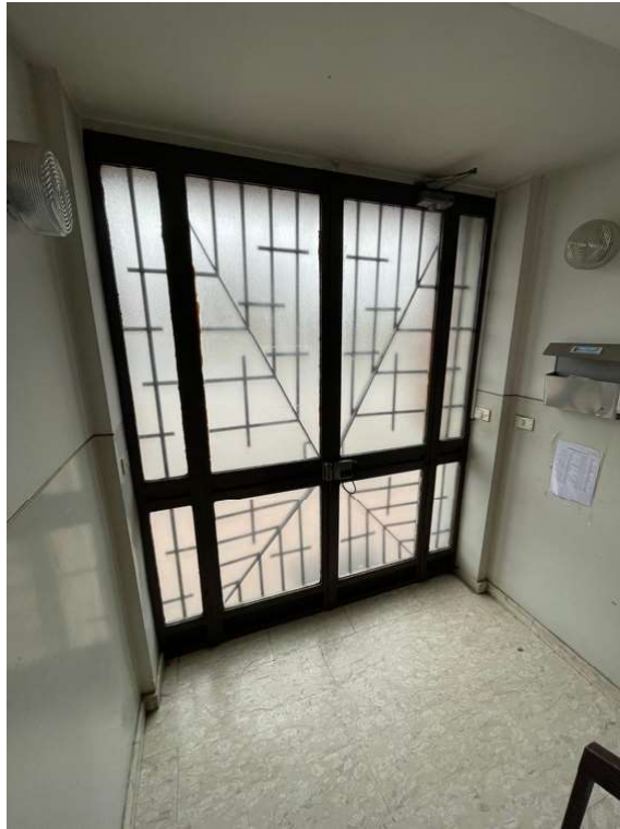
Fotografia A.29 - Portone condominiale
