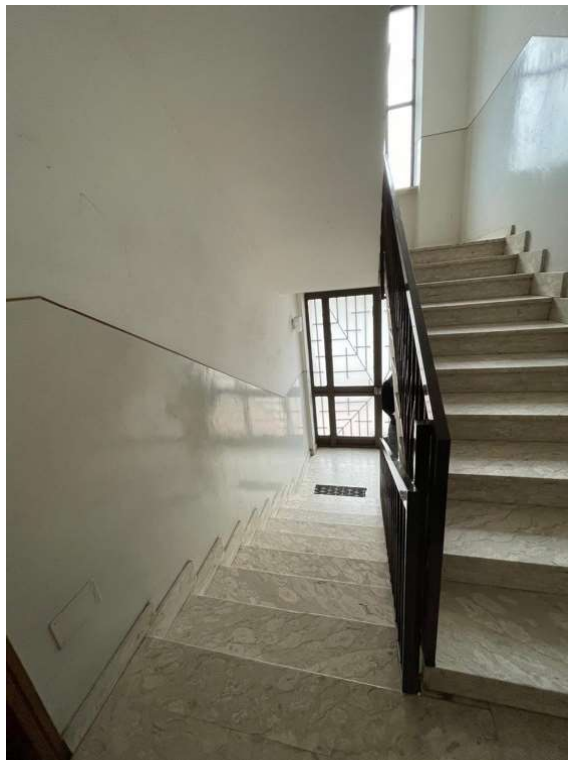
Fotografia A.30 - Vano scala condominiale
