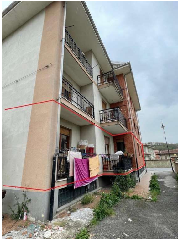
Fotografia A.5 - Esterno stabile su area esterna condominiale
