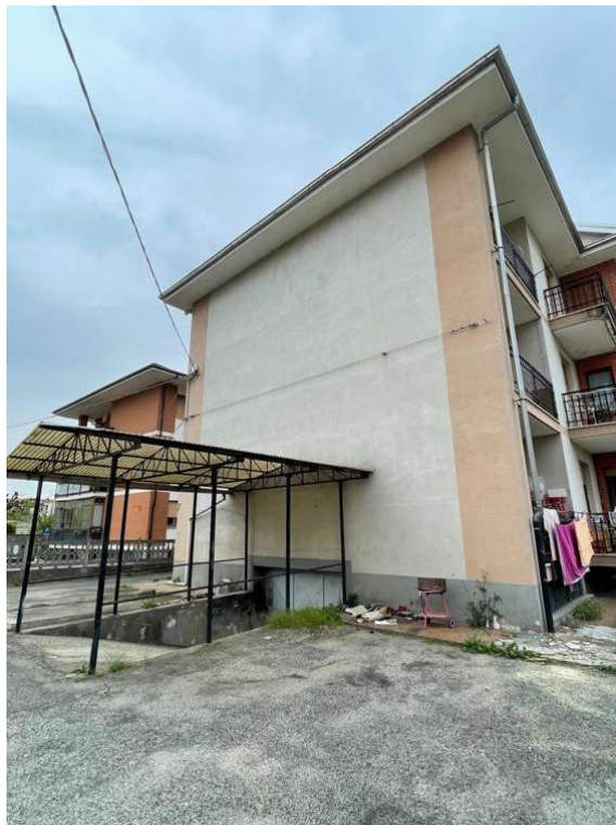
Fotografia A.6 - Esterno stabile su area esterna condominiale
