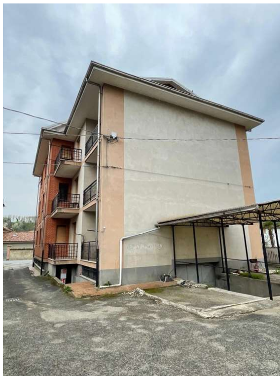
Fotografia A.7 - Esterno stabile su area esterna condominiale
