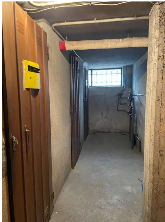
Fotografia A.32 - Corridoio cantine
