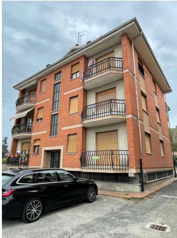
Fotografia A.3 - Esterno stabile su Via Torino
