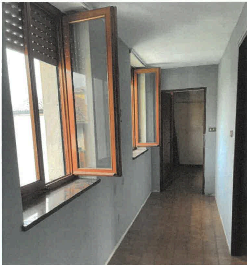
Corridoio disimpegno al Primo Piano Caresana -
