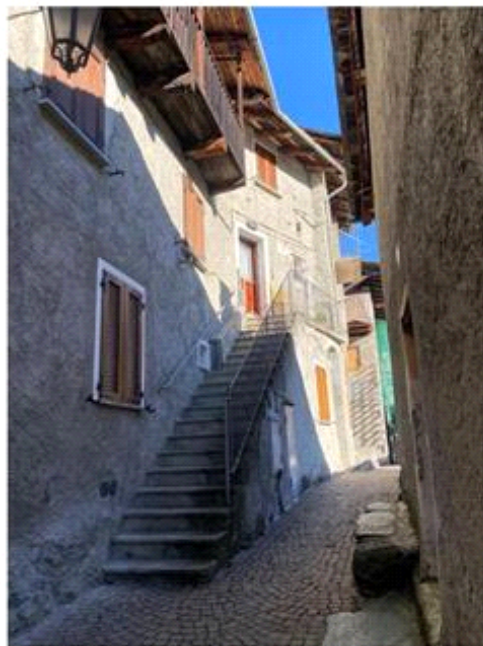
Facciata esposta a sud. Particolare ingresso appartamento posto ai piani 1-2
