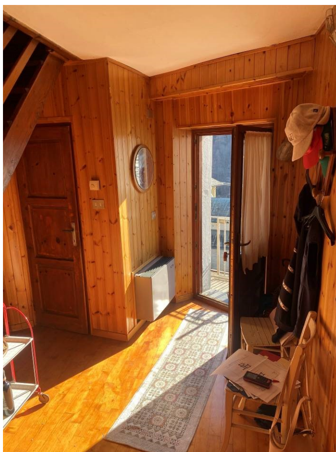
Particolare disimpegno d'ingresso al piano primo.
