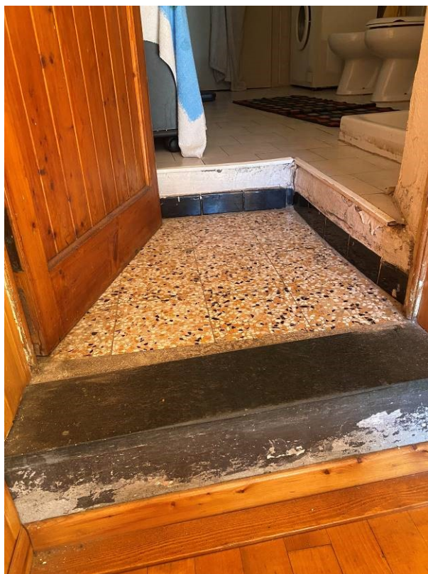
Piano primo: gradini di accesso al bagno/cantina dal disimpegno.
