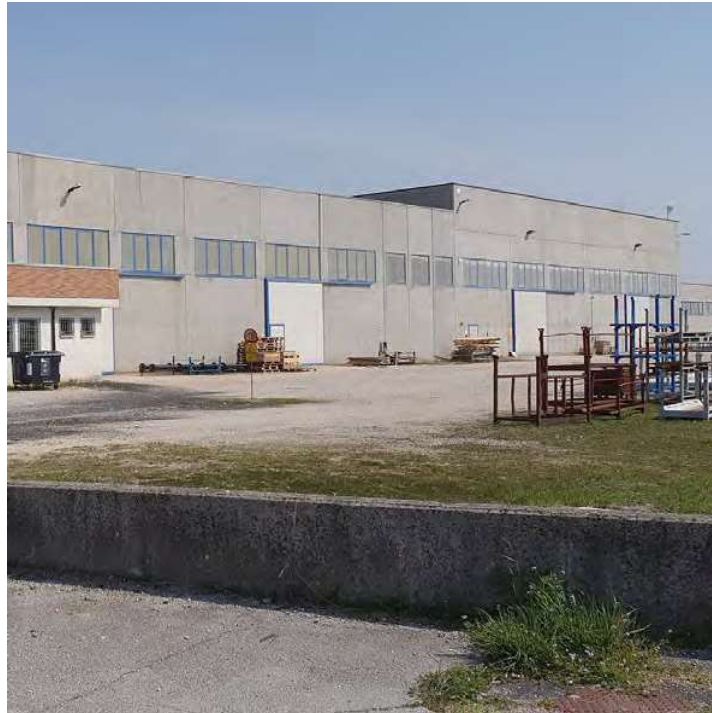
Figura 15: Calto - Esterno stabilimento
