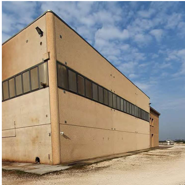
Figura 23: Ficarolo - vista laterale capannone
