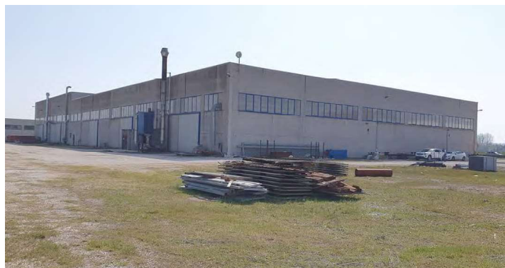
Figura 16: Calto - Esterno stabilimento
