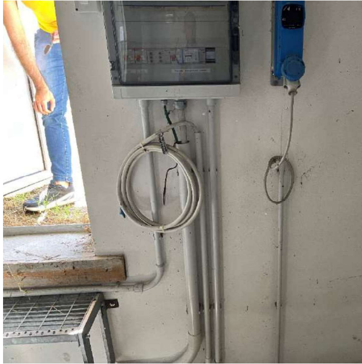
Figura 16 – interno locale pozzo senza danni
