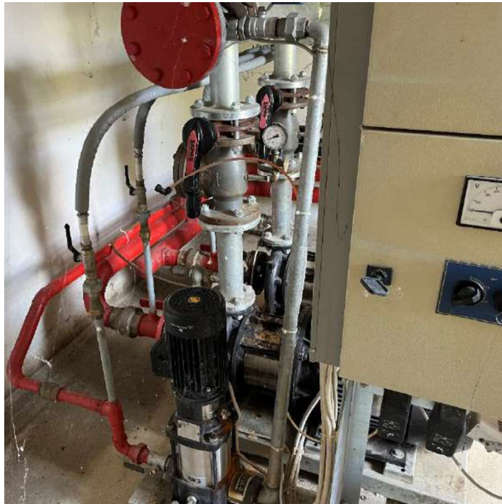
Figura 17- interno locale pozzo senza danni
