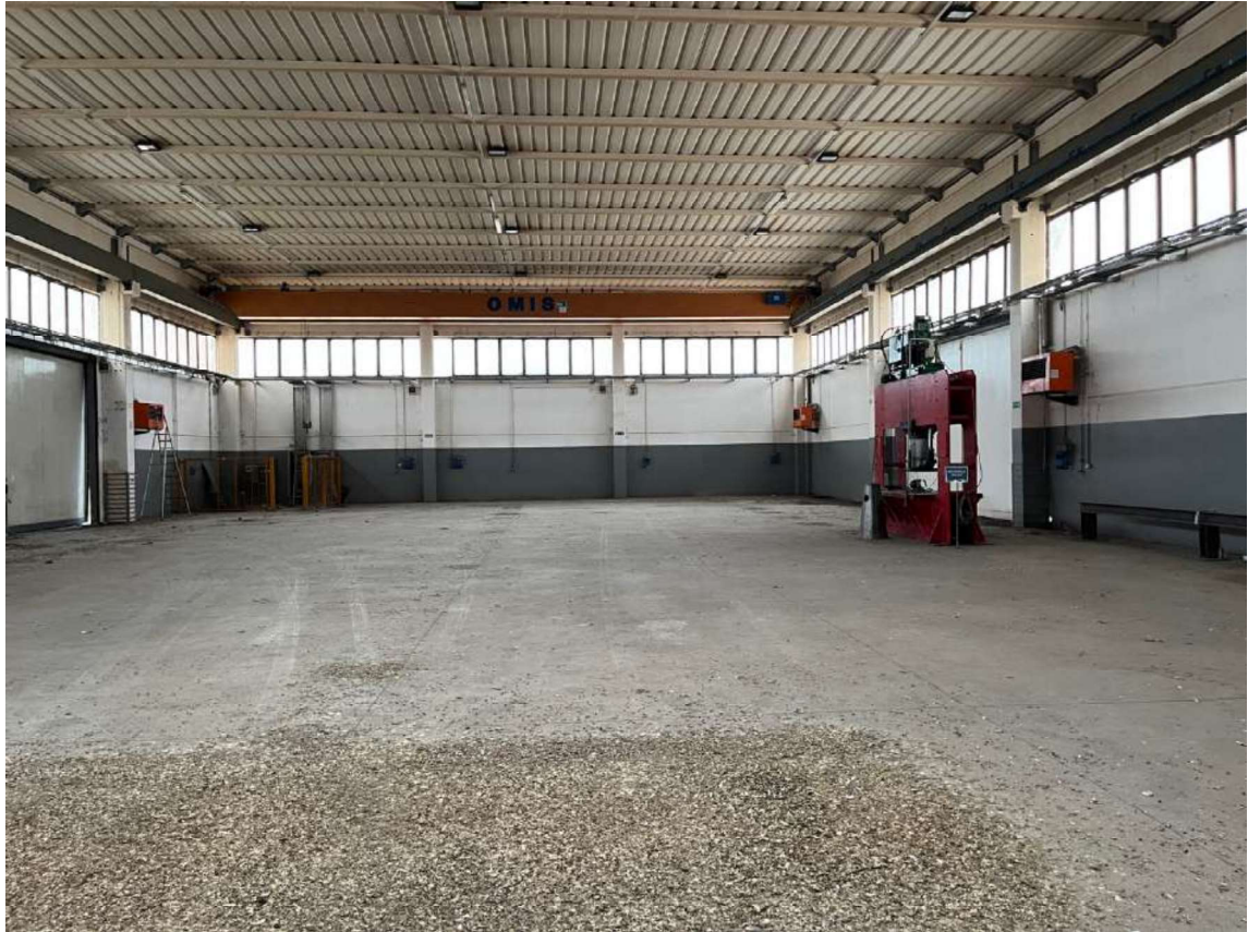
Figura 7- vista interna del capannone
