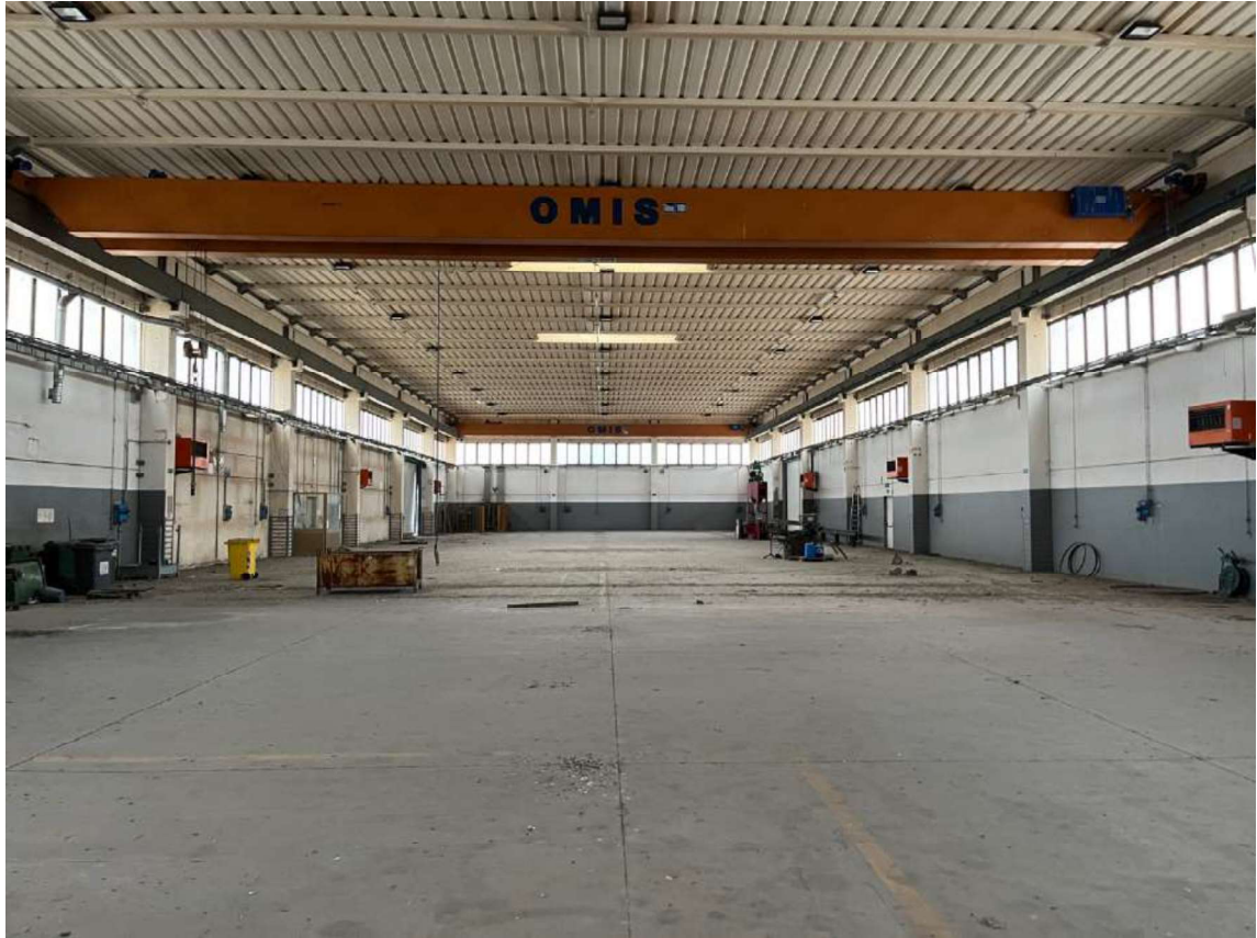
Figura 6- vista interna del capannone
