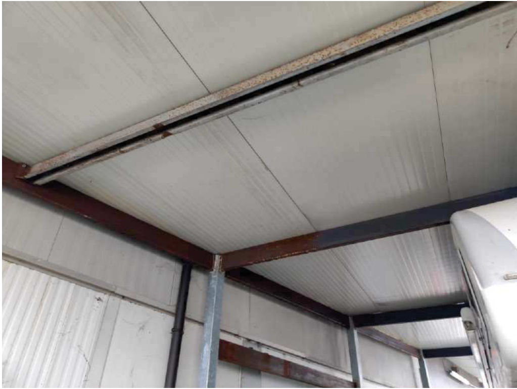
FOTO N. 49 (porzioni da demolire)
