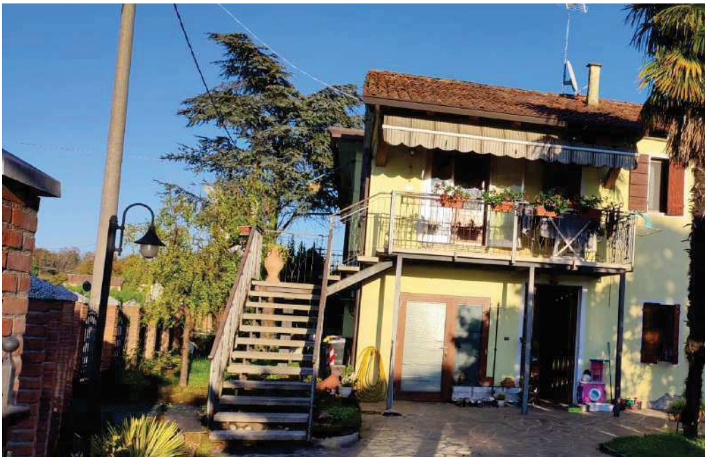
FOTO N. 28 (alloggio piano primo)
