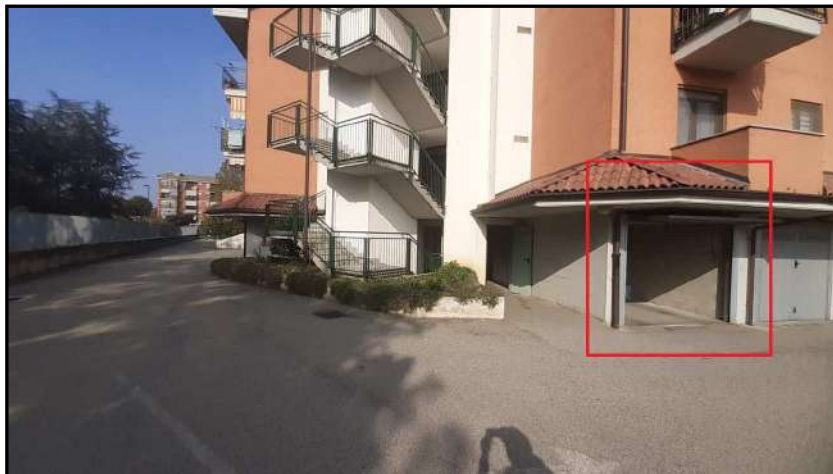
Fotografia 24 – Nel riquadro rosso si evidenzia accesso Autorimessa privata in oggetto.
