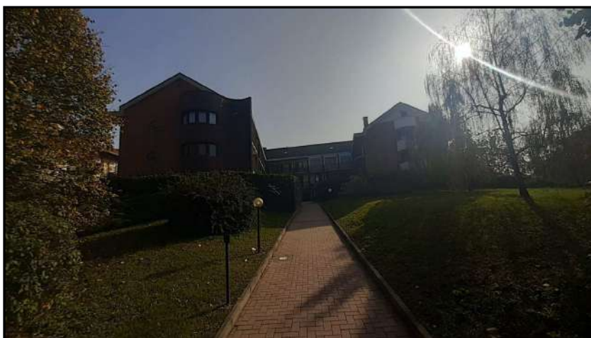
Fotografia 05 – Percorso pedonale di accesso al vano scala condominiale
