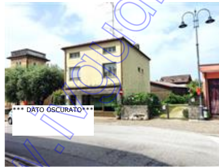
Veduta principale su via Roma
