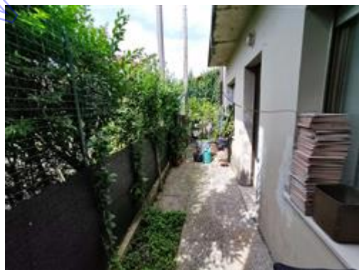
Cortile interno Sub. 4
