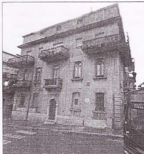
Facciata del fabbricato su Via Generale Pennella
