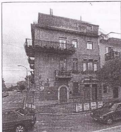
Facciata del fabbricato su Parco della Rimembranza
