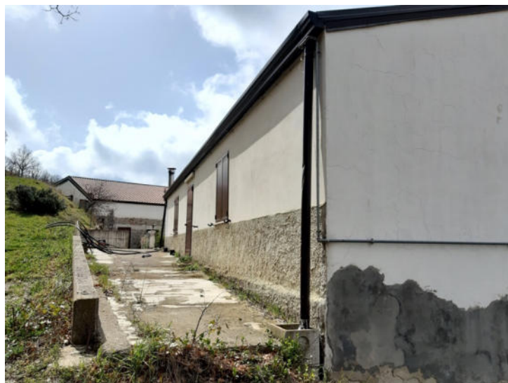
Foto n. 34 – Fabbricato B - Vista esterna
