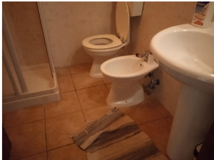
Foto n. 22 – Fabbricato A - Piano primo - Vista interna - Part. 477
