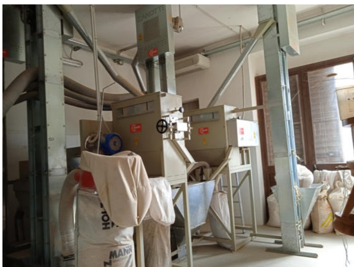
Foto n. 37 – Fabbricato B - Piano terra - Vista interna - Part. 476 sub2
