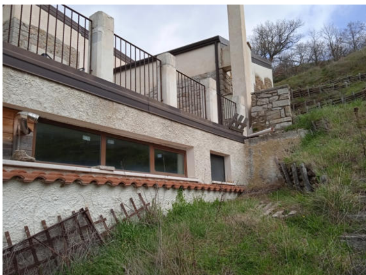
Foto n. 7 – Fabbricato A - Vista esterna
