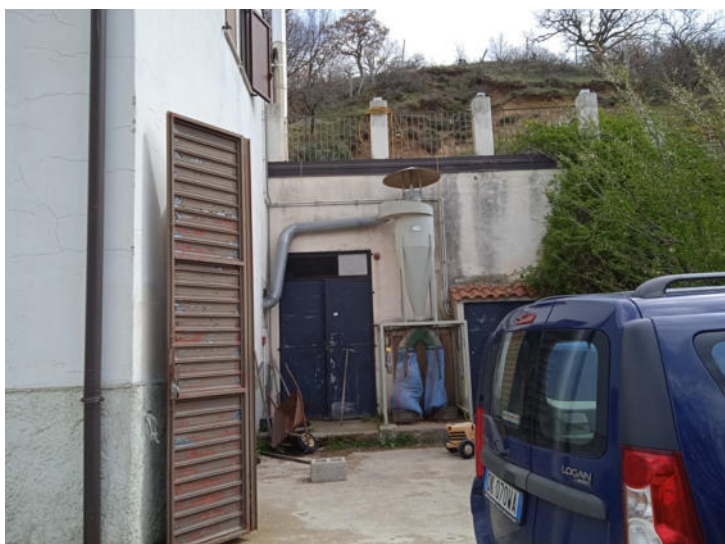
Foto n. 35 – Fabbricato B - Vista esterna
