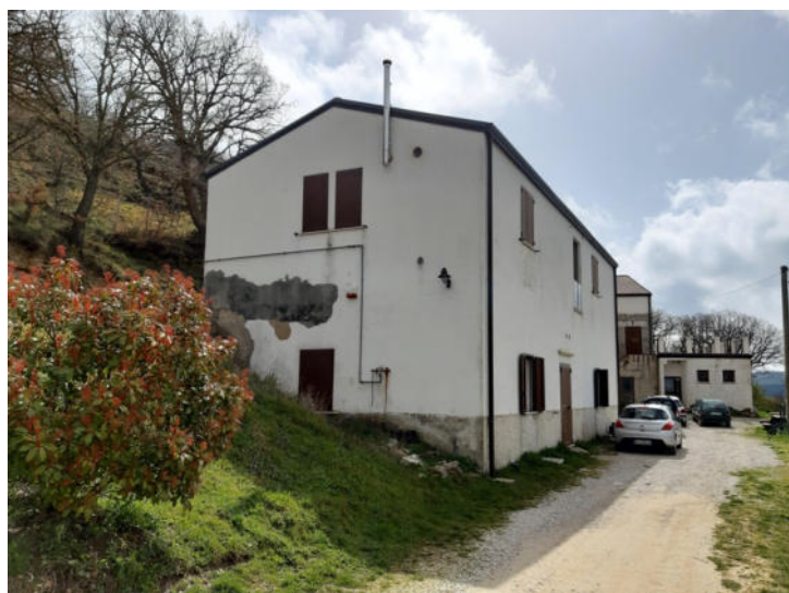
Foto n. 30 – Fabbricato B - Vista esterna
