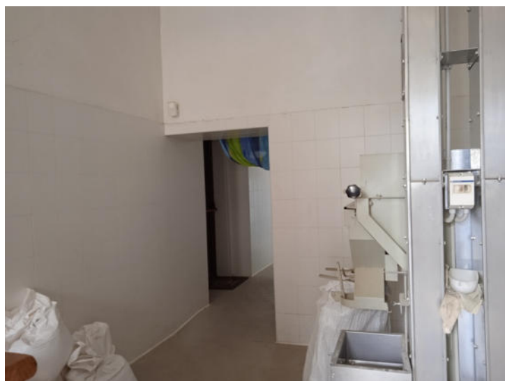
Foto n. 38 – Fabbricato B - Piano terra - Vista interna - Part. 476 sub2
