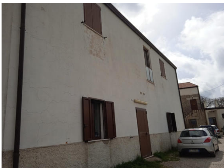
Foto n. 31 – Fabbricato B - Vista esterna
