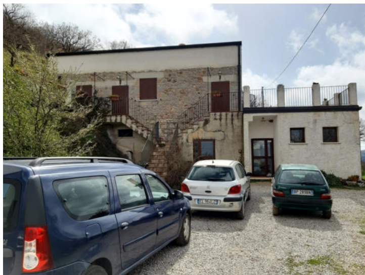
Foto n. 4 – Fabbricato A - Vista esterna
