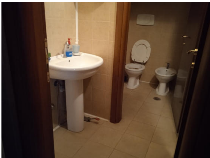
Foto n. 17 – Fabbricato A - Piano terra - Bagno - Part. 477
