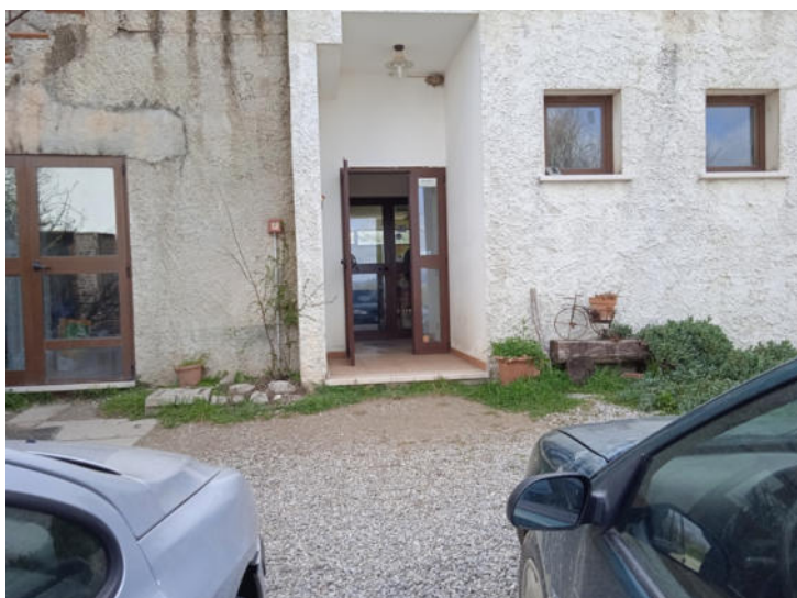
Foto n. 5 – Fabbricato A - Vista esterna
