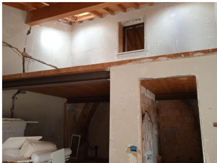
Foto n. 26 – Fabbricato A - Piano primo - Vista interna - Part. 477
