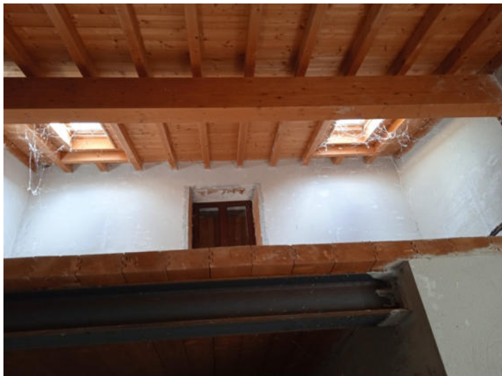
Foto n. 27 – Fabbricato A - Piano primo - Vista interna - Part. 477
