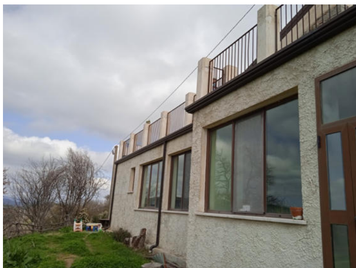
Foto n. 6 – Fabbricato A - Vista esterna
