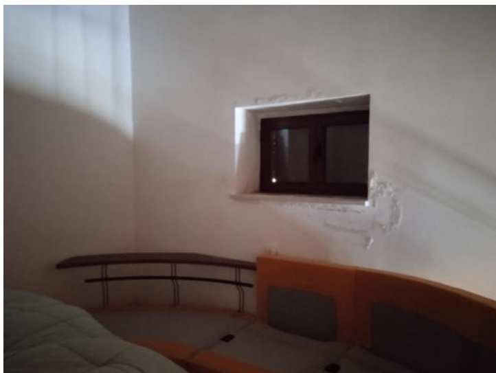
Foto n. 19 – Fabbricato A - Piano primo - Vista interna - Part. 477
