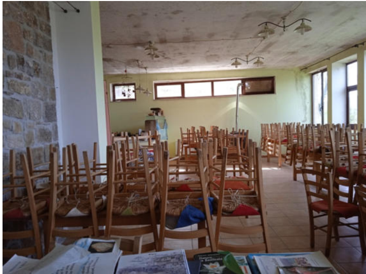
Foto n. 11 – Fabbricato A - Piano terra - Sala da pranzo - Part. 477
