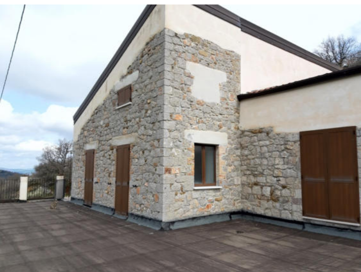
Foto n. 8 – Fabbricato A - Vista esterna
