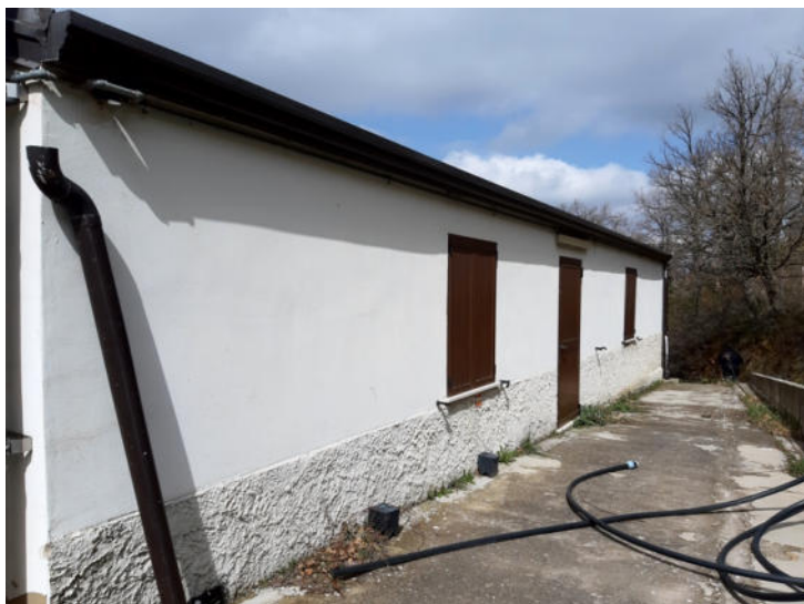
Foto n. 33 – Fabbricato B - Vista esterna
