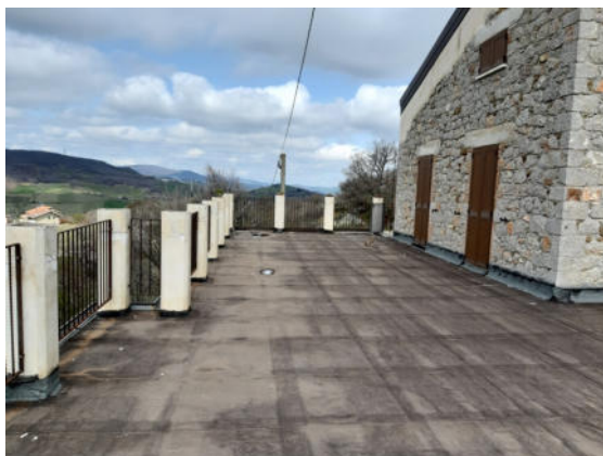
Part. 477 - Vista terrazzo piano primo
