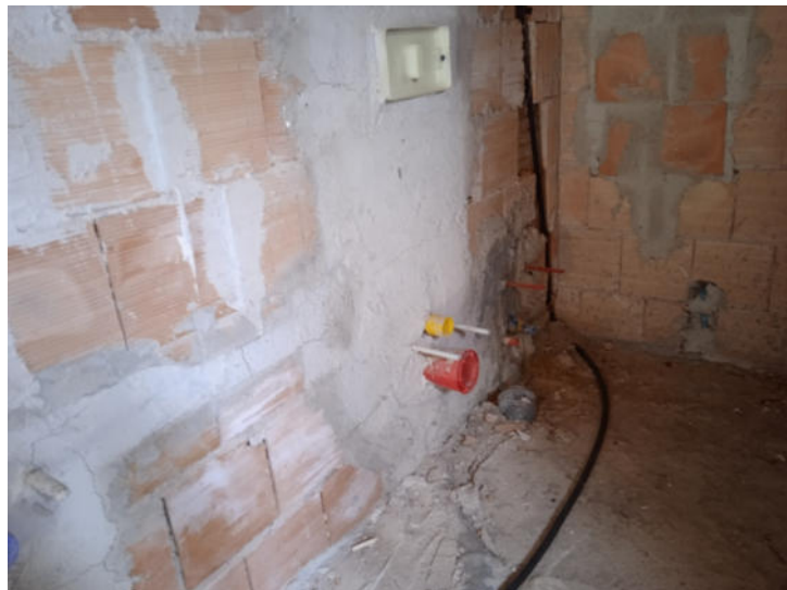
Foto n. 28 – Fabbricato A - Piano primo - Vista interna - Part. 477
