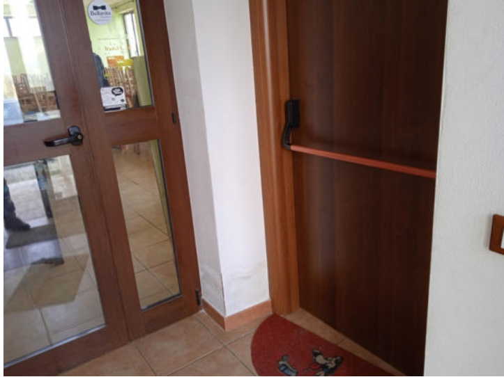
Foto n. 9 – Fabbricato A - Piano terra - Ingresso - Part. 477
