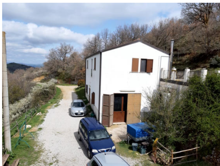
Foto n. 32 – Fabbricato B - Vista esterna
