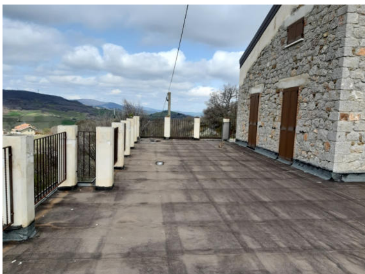
Foto n. 29 – Fabbricato A - Piano primo - Terrazza - Part. 477
