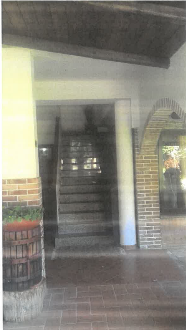
Scala di accesso al piano primo
