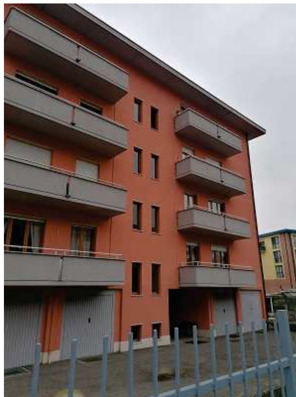
Vista d'insieme del condominio
