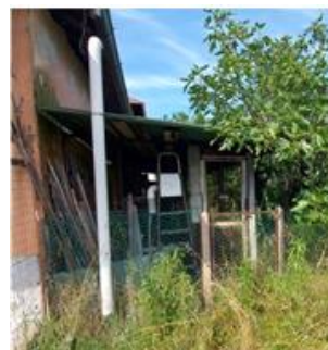
Tettoia da demolire
