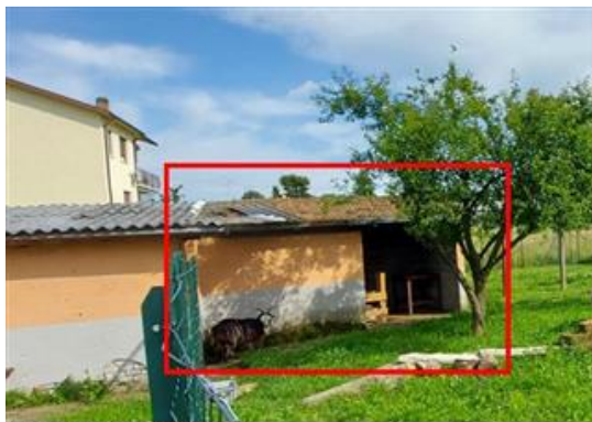
corpo accessorio da demolire
