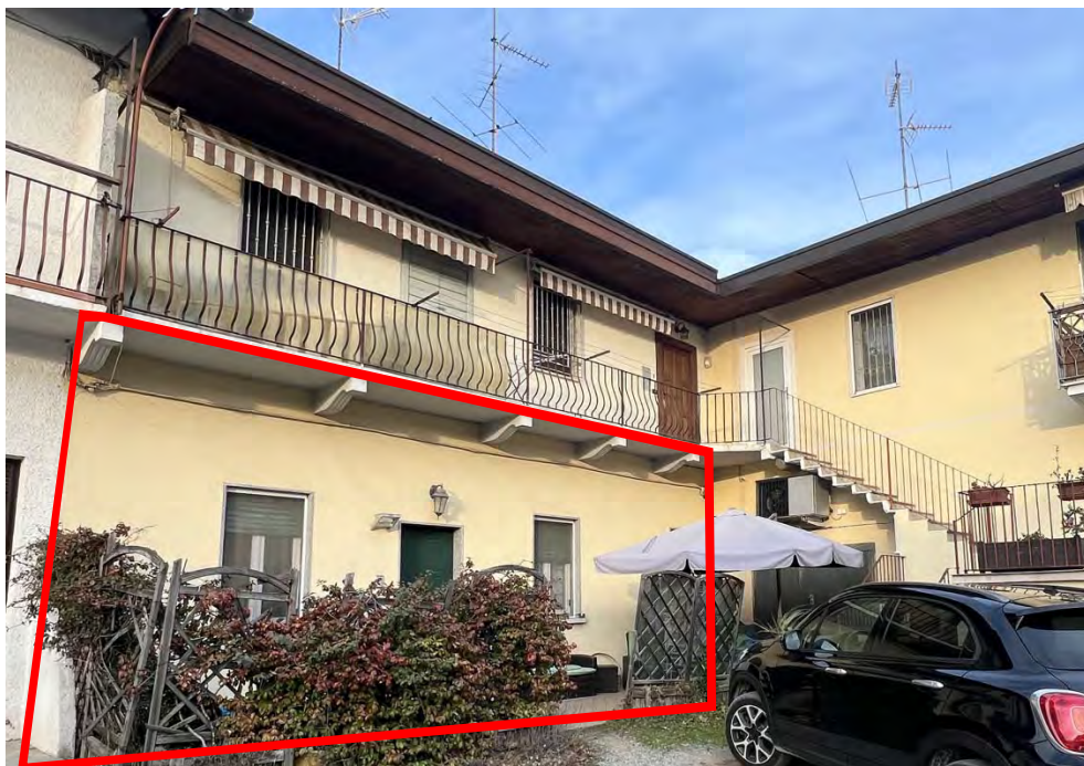
Facciata su cortile oggetto di pignoramento
