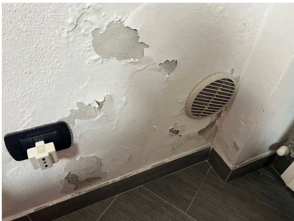
Scrostamento zoccolo interno
