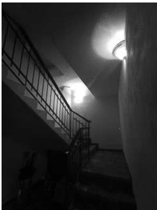
Vista vano scala (terra-1°)
