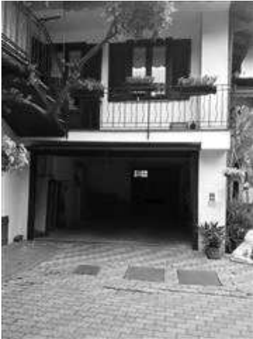
Vista esterna autorimessa
