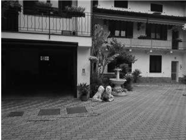
Vista facciata box/abitazione (dalla corte interna)
