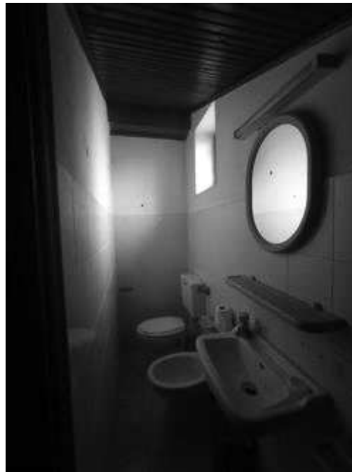
Vista wc sottotetto
