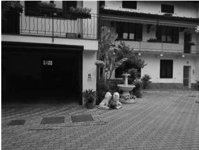
Vista facciata box/abitazione (dalla corte interna)
