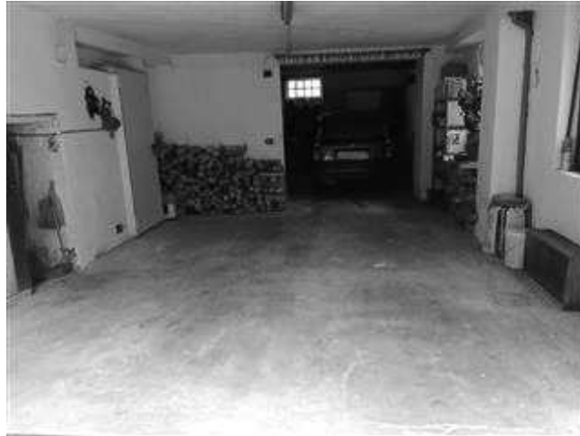
Vista interna autorimessa (1° vano)
