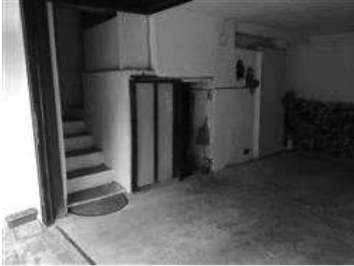
vista vano 1 con scala interna
