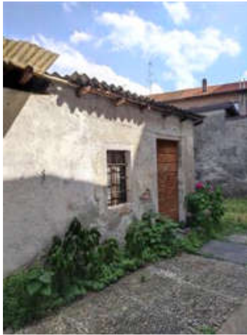
Vista lato Ovest
