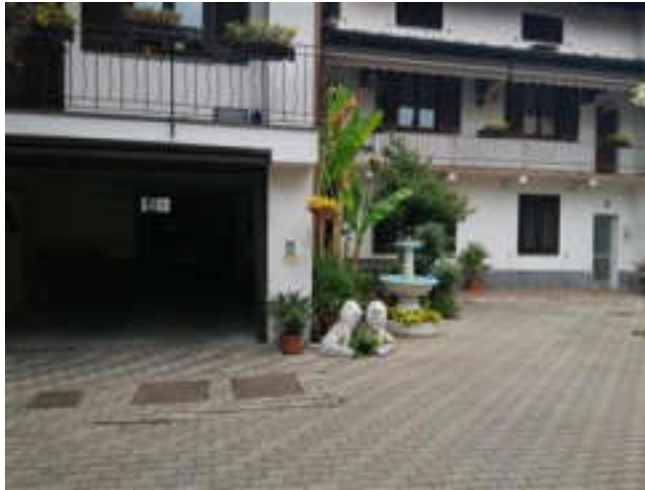
Vista facciata box/abitazione (dalla corte interna)
