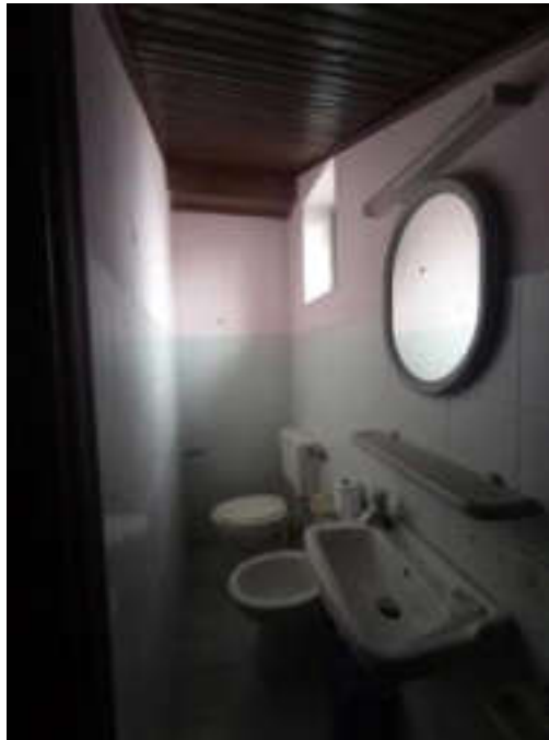
Vista wc sottotetto
