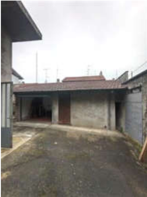
Vista fabbricato accessorio a confine
