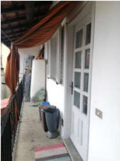
Vista ballatoio d'accesso
