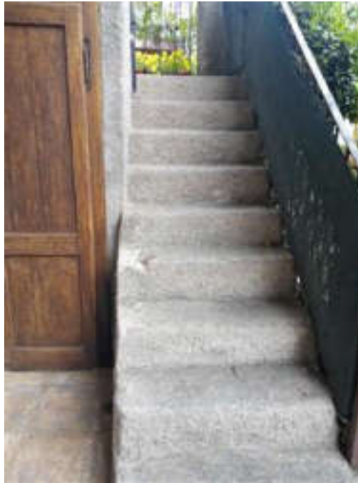
particolare rampa scala esterna
