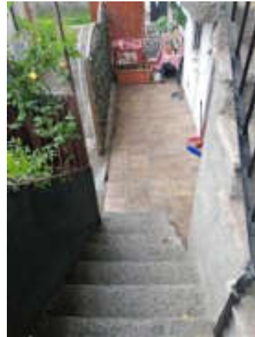
Vista scala esterna
