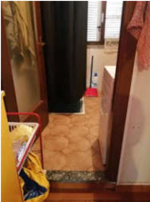
particolare pavimentazione wc
