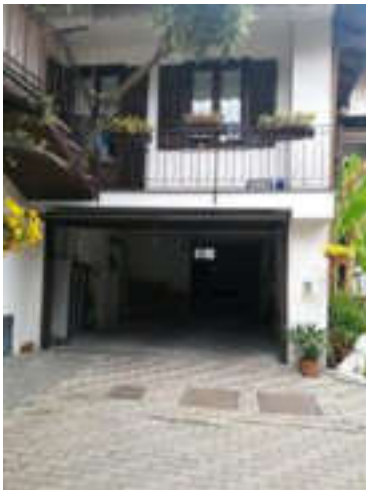
Vista esterna autorimessa
