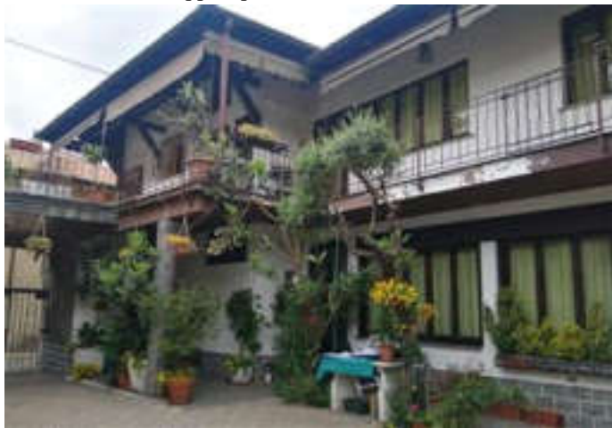
VISTA UNITA' PT-PI° DAL CORTILE INTERNO
