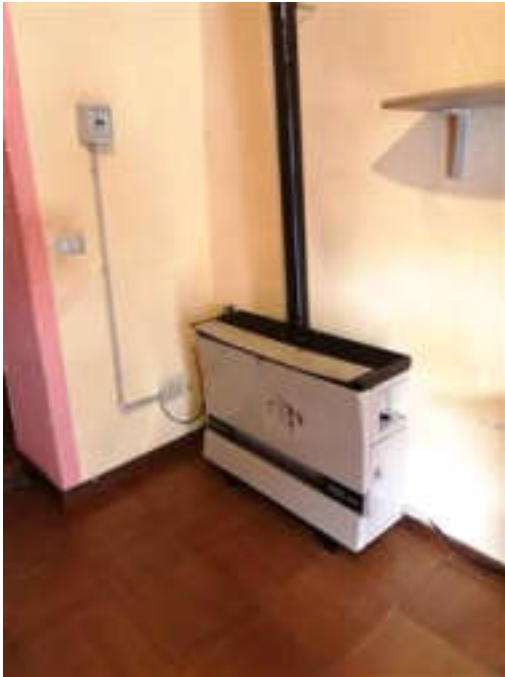
particolare stufa esistente
