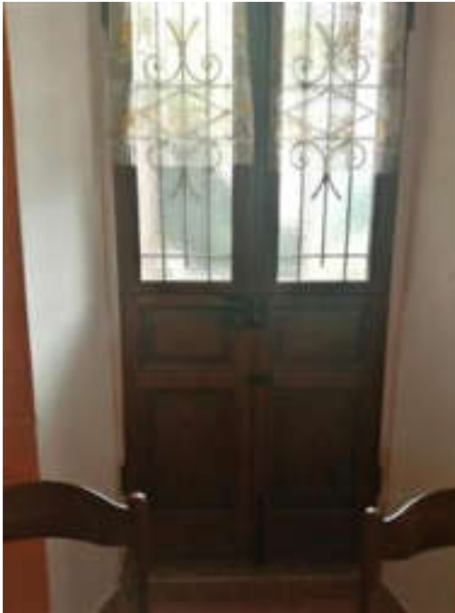
particolare porta di collegamento al cortile
