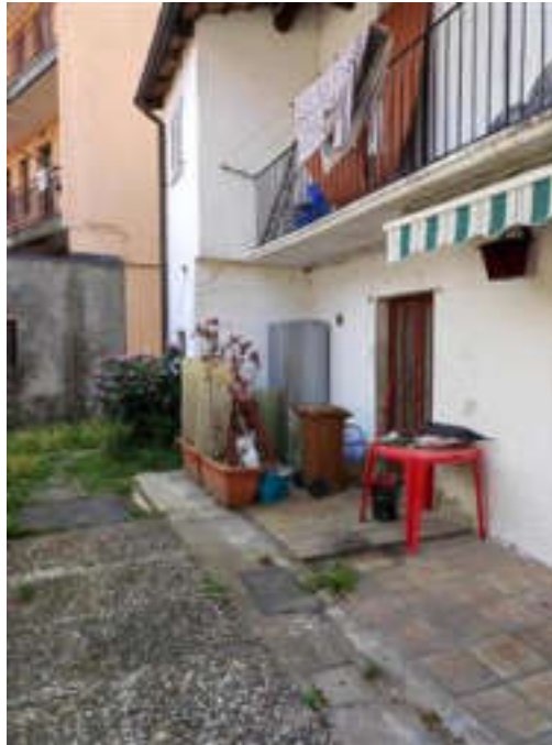
Vista da cortile interno
