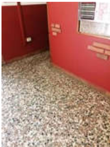
Particolare pavimentazione in marmette
