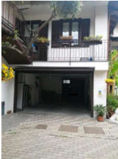
Vista facciata box/abitazione
