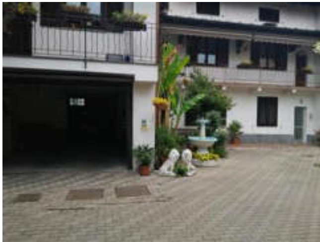
Vista facciata box/abitazione (dalla corte interna)
