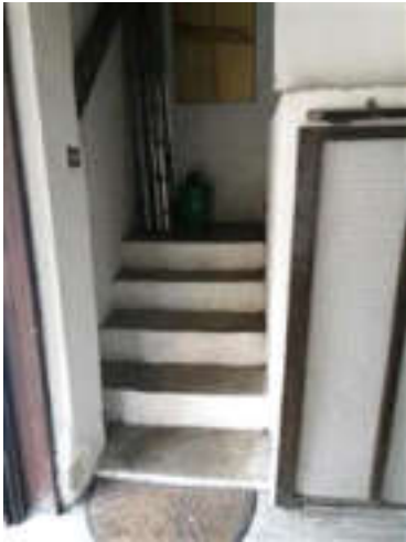
particolare scala interna
