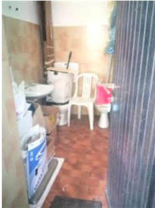
vista servizio igienico
