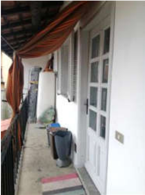
Vista ballatoio d'accesso
