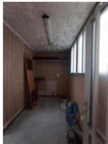
Vano con pareti e solaio prefabbricati
