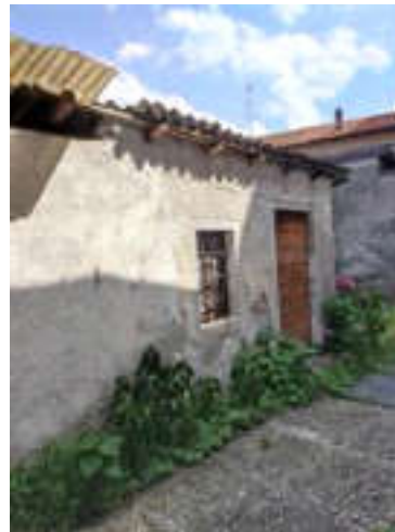
Vista lato ovest
