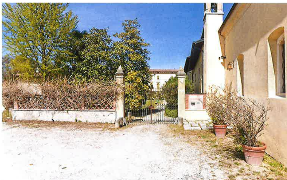
Figura 28: ripresa fotografica dell'ingresso carraio che si apre sulla corte esterna identificata con la particella 1184 sub 7
