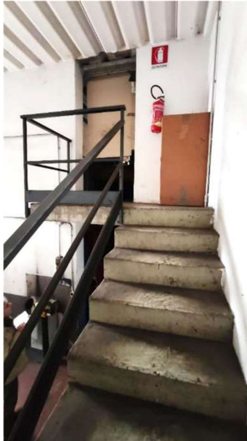
. -scala accesso Locale tecnico al locale soppalco-
