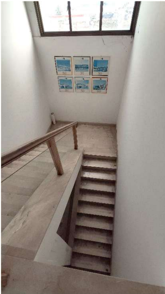
S.p.a. - Vano scala -
