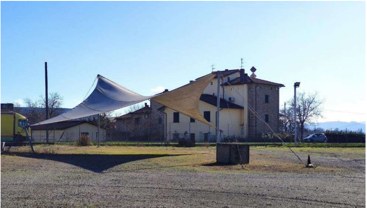
Copertura non autorizzata
