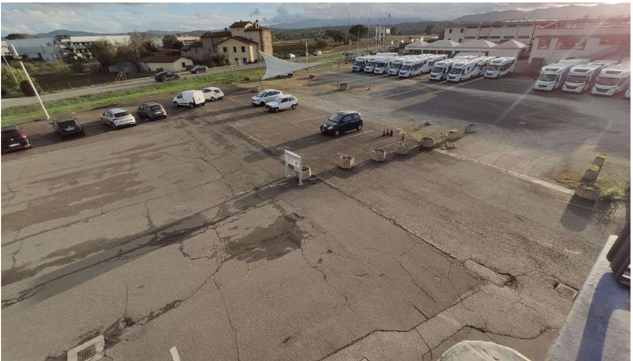
-Piazzali lato Sud - Ovest -
