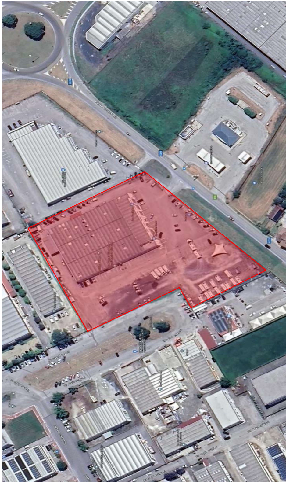
Vista satellitare con evidenziata l'area del complesso immobiliare della U.N. 1
