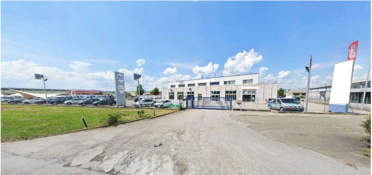
Ingresso principale su via Senese Aretina Aretina n.c. 300
