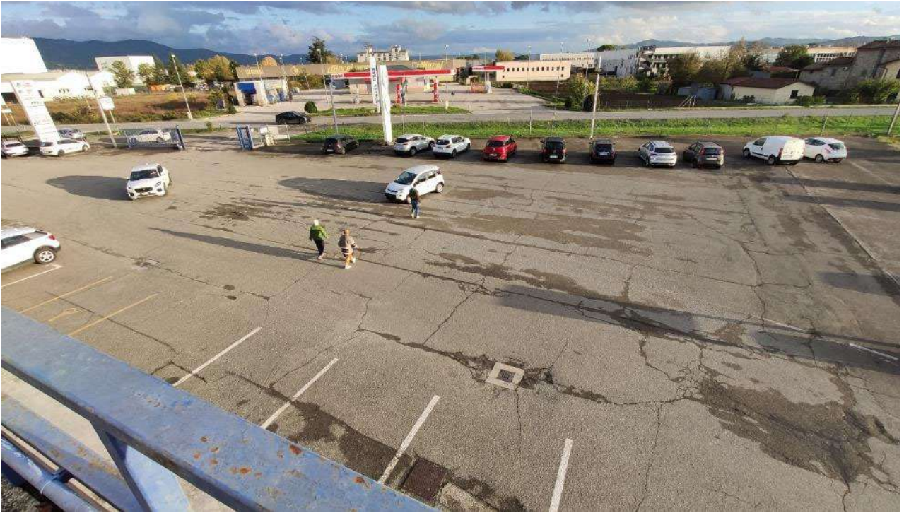
. -Piazzali lato Sud -
