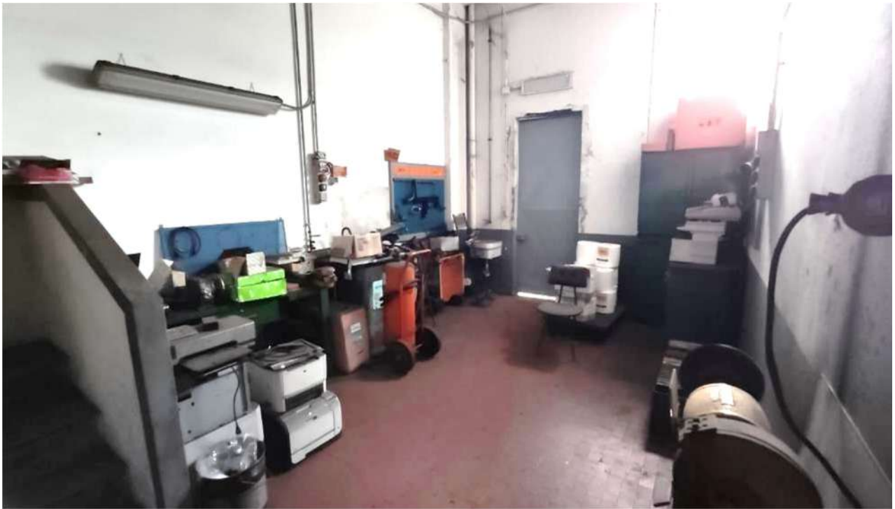
. -Locale tecnico P.T.-
