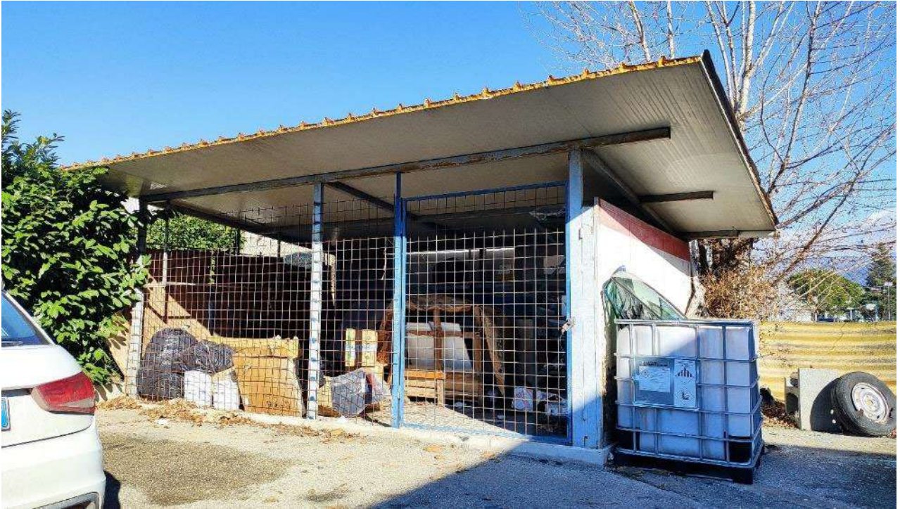
Tettoia non autorizzata
