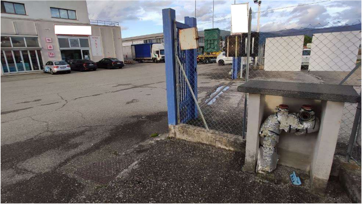
Cancelli ingressi principali su via Senese Aretina, n.c. 300
