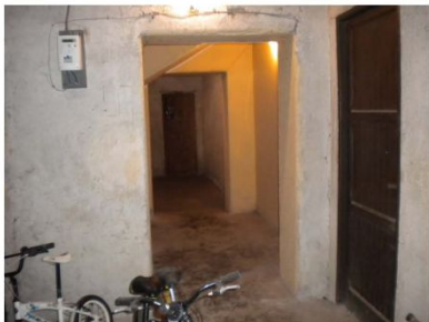
Foto 19- Corridoio piano interrato
