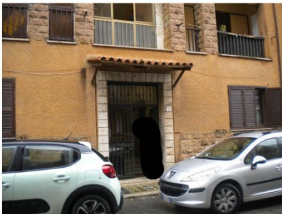
Foto 2- Particolare ingresso scala.
