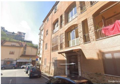
Foto 1- Panoramica edificio lato ingresso principale
