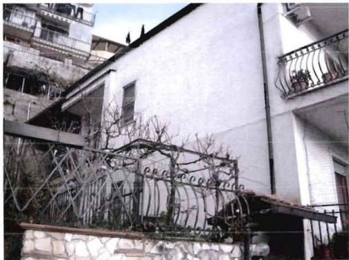
FOTO 4 (Prospetto Laterale OVEST)
