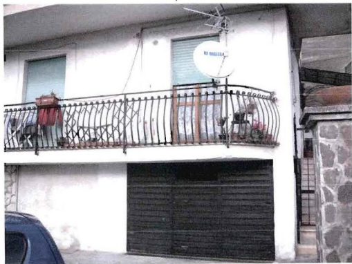
FOTO 2 (Prospetto Frontale ed Ingresso Pertinenza)
