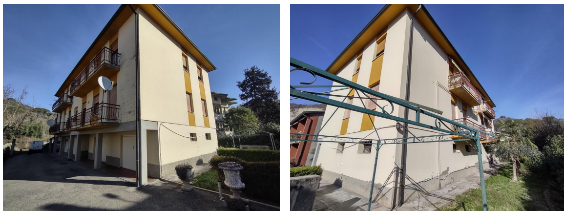
La palazzina condominiale: vista del fronte ad angolo con prospetto su Via XXV Aprile e del retro,
