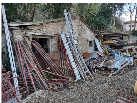
Deposito in sasso con annessa tettoia interessato da movimenti franosi (part.IIa 92)
