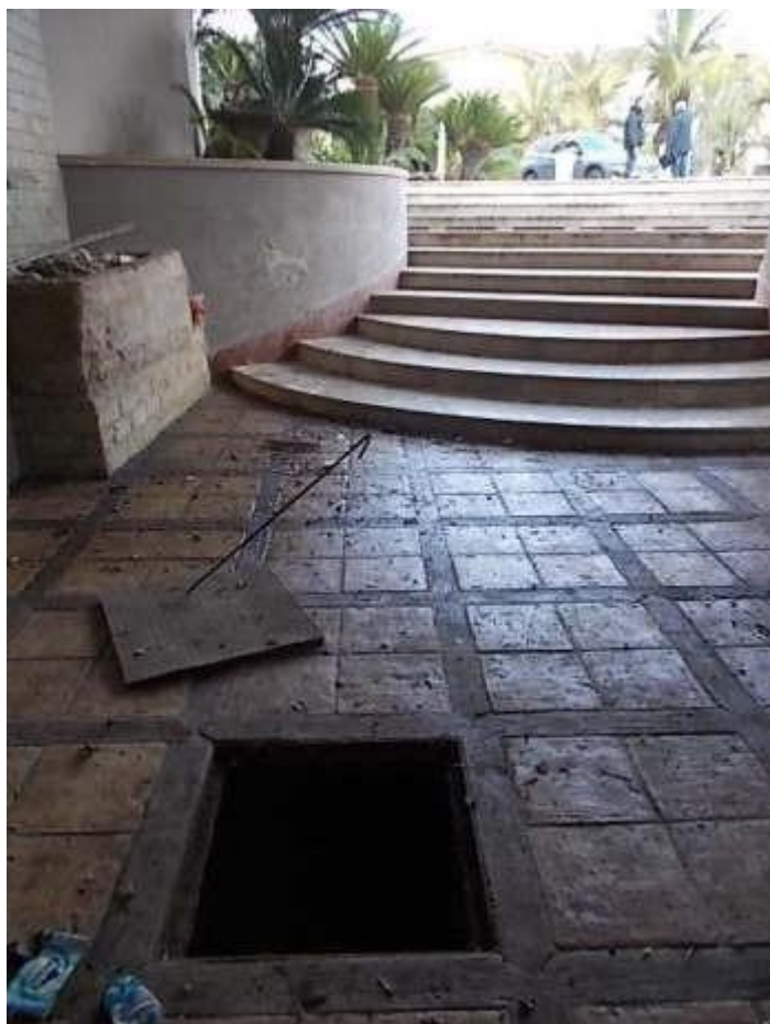
viste dell'ingresso al piano seminterrato dove sono posti alcuni pozzetti di intercettazione del collettore fognario
