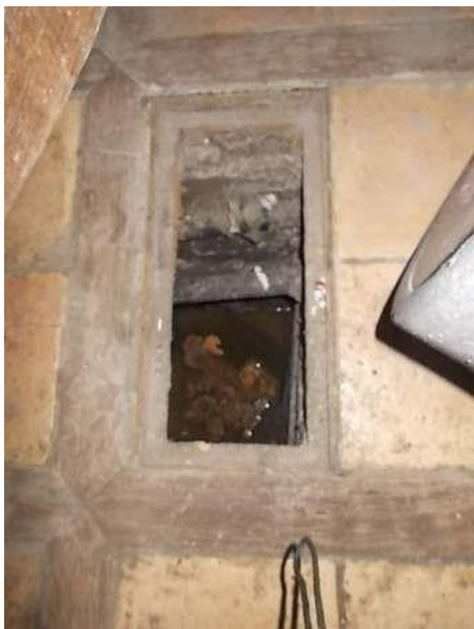
viste dell'ingresso al piano seminterrato dove sono posti alcuni pozzetti di intercettazione del collettore fognario
