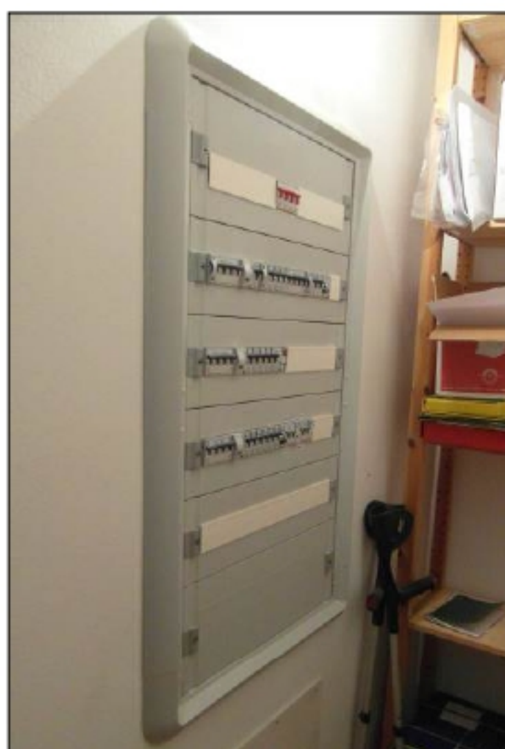
foto 2 – Q.E. Loc. Ripostiglio
