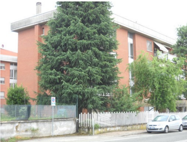
Prospetto lato strada
