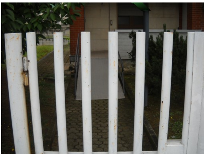
Cancello pedonale al servizio rampa disabili
