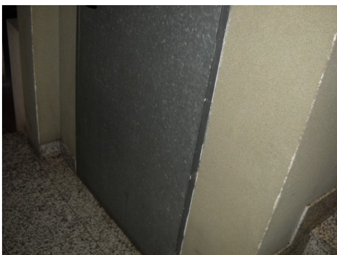
Cantina piano interrato
