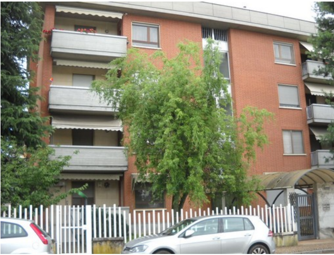
Prospetto lato strada
