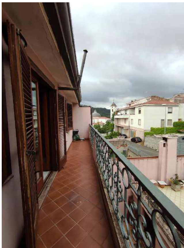
Figura 86- vista 83, balcone con accesso dal sub.7
