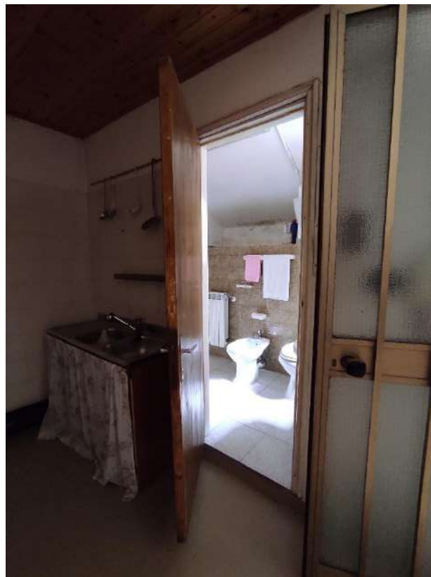
Figura 38- vista 34, sub. 6, accesso al bagno (sub.5)
