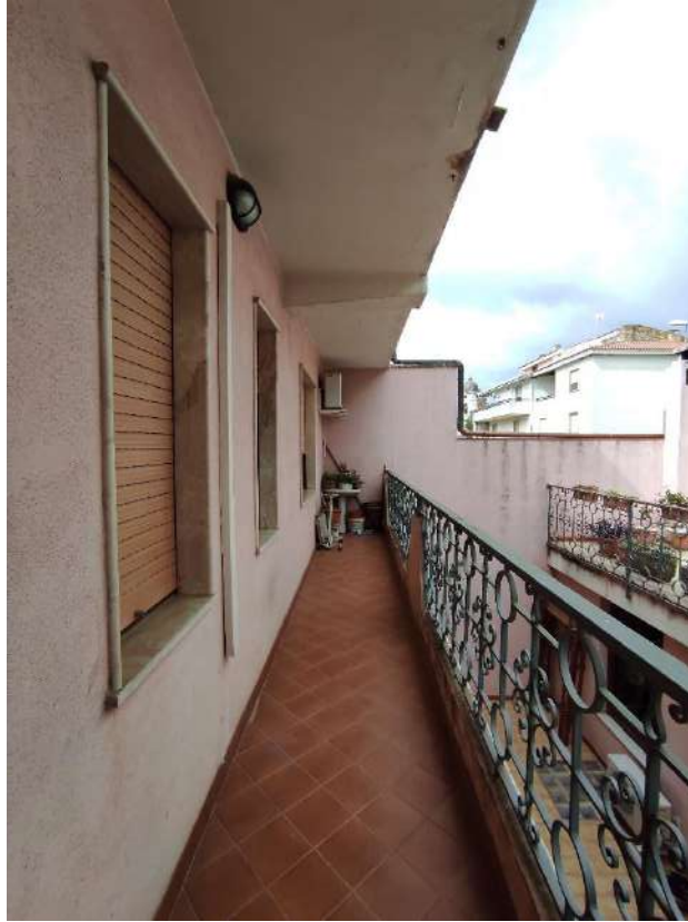
Figura 64- vista 61, balcone con accesso dal sub.6
