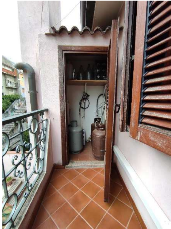
Figura 88- vista 85, balcone con accesso dal sub.7
