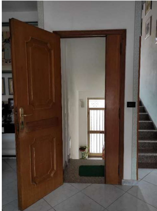
Figura 47- vista 43, ingresso al sub.6, piano secondo
