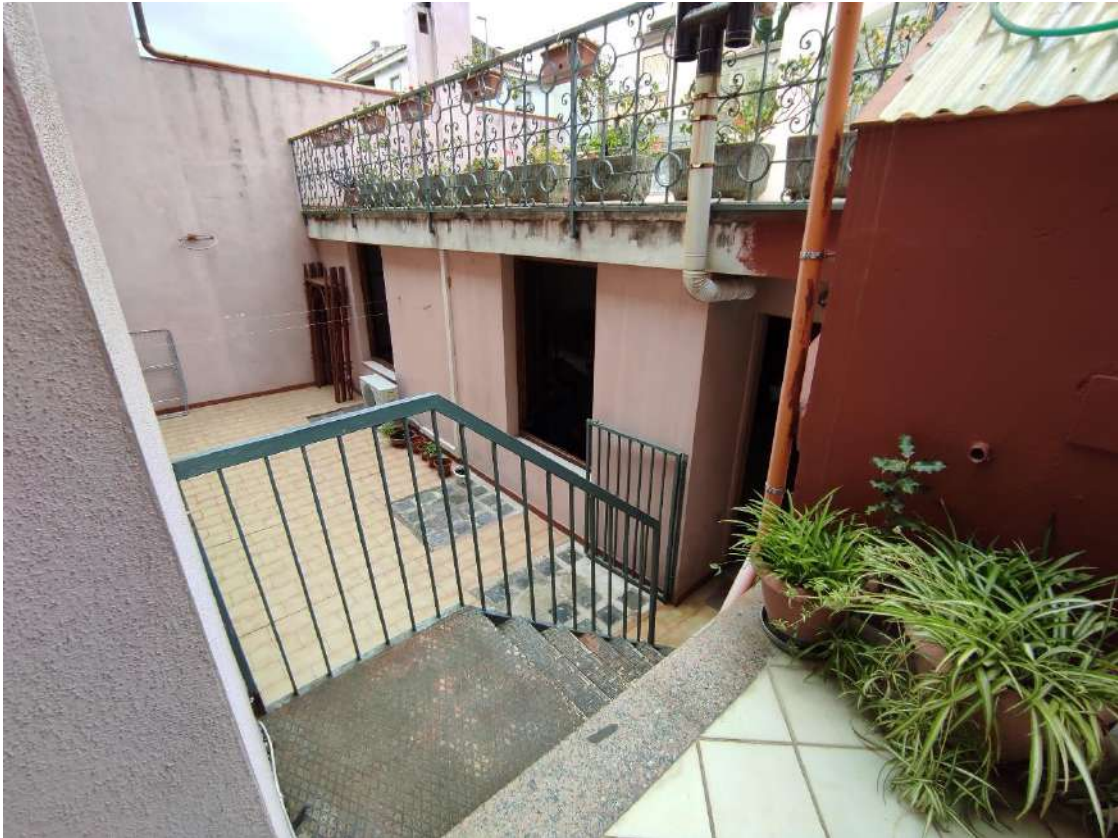
Figura 41- vista 37, sub.6, terrazza, vista verso il sub.5
