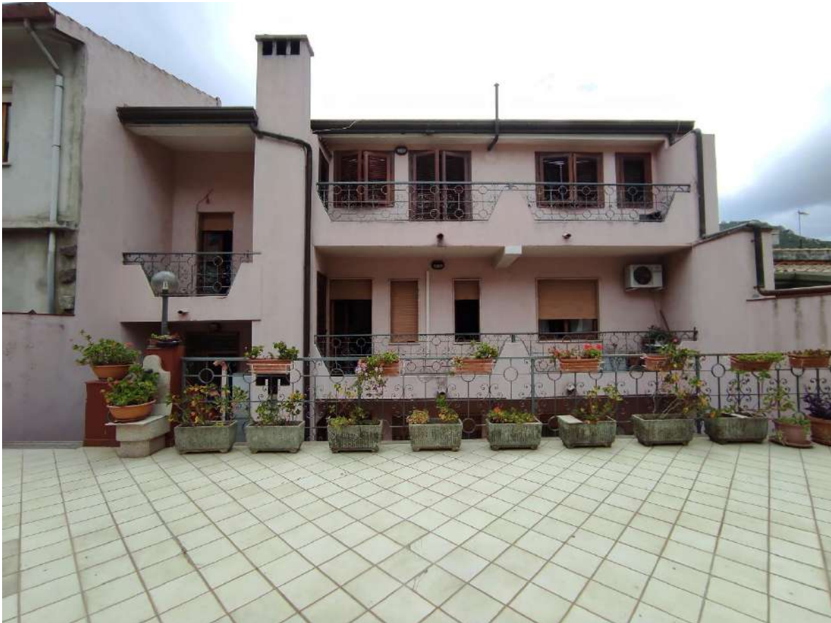
Figura 89- vista 86, vista dal sub.6, terrazza scoperta
