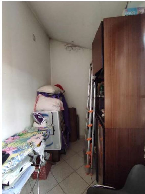
Figura 83- vista 80, sub.7, ripostiglio
