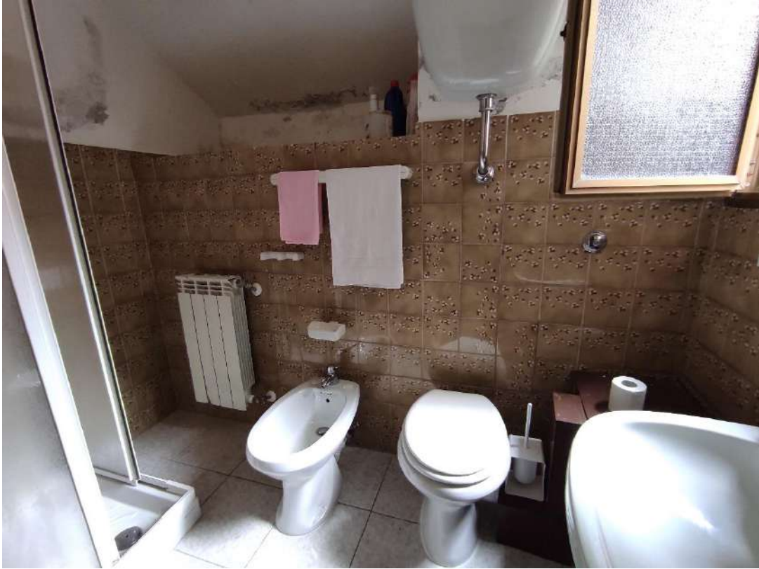
Figura 39_vista 35, sub.5, bagno
