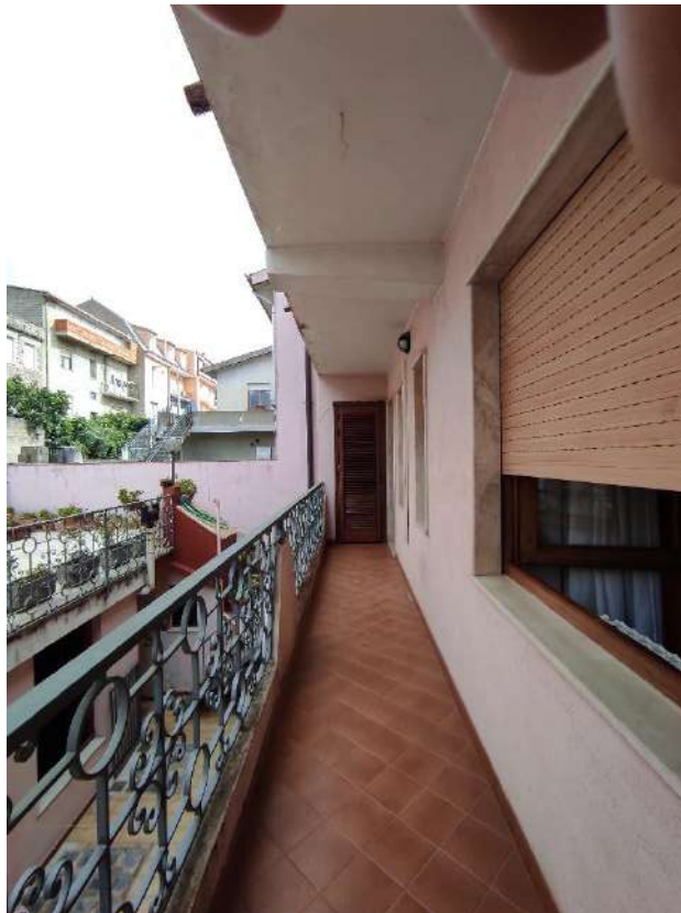
Figura 65- vista 62, balcone con accesso dal sub.6
