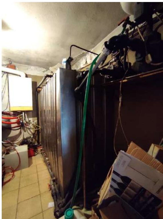
Figura 11- vista 7 sub.8, locale tecnico
