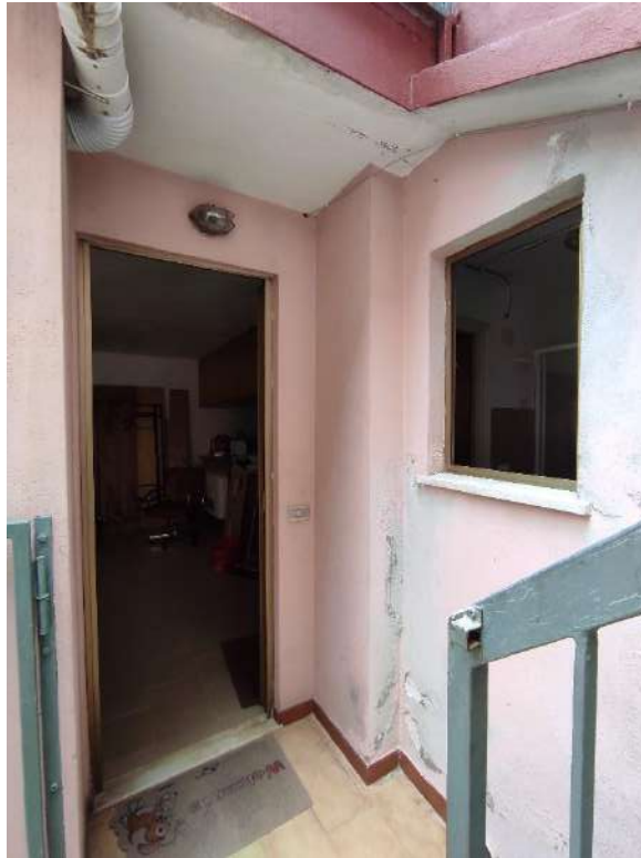
Figura 33- vista 29, sub.5, accesso al sub.6
