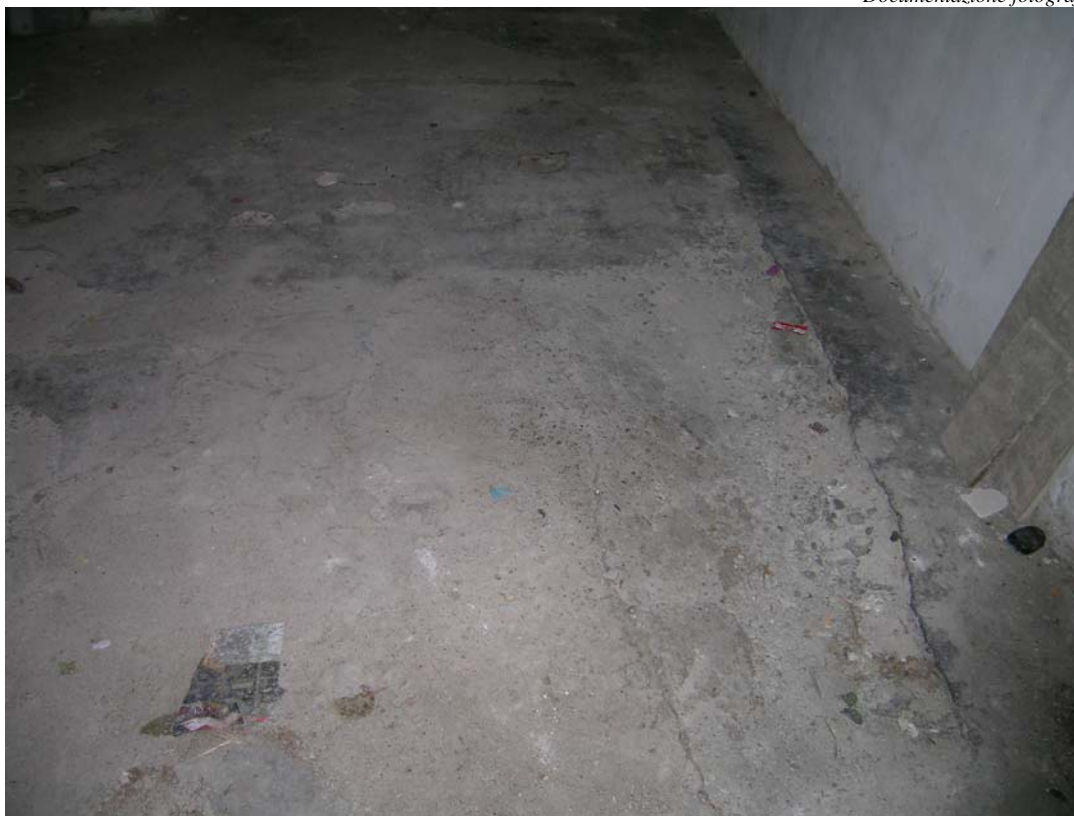
Foto n. 7 Interno lotto 1 – Dettaglio pavimento
