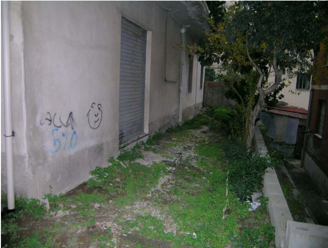
Foto n. 9 Cortile sul retro. Si nota la serranda di accesso del lotto 2 e, in fondo, le finestre del lotto 1.
