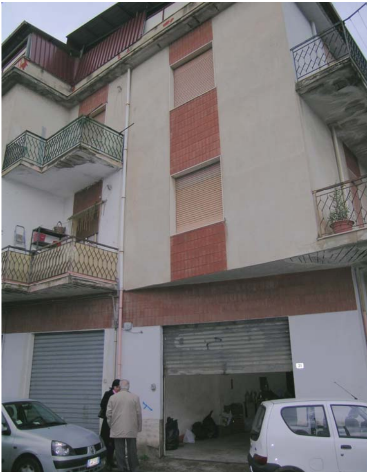
Foto n. 1 Edificio visto da via XX Febbraio
