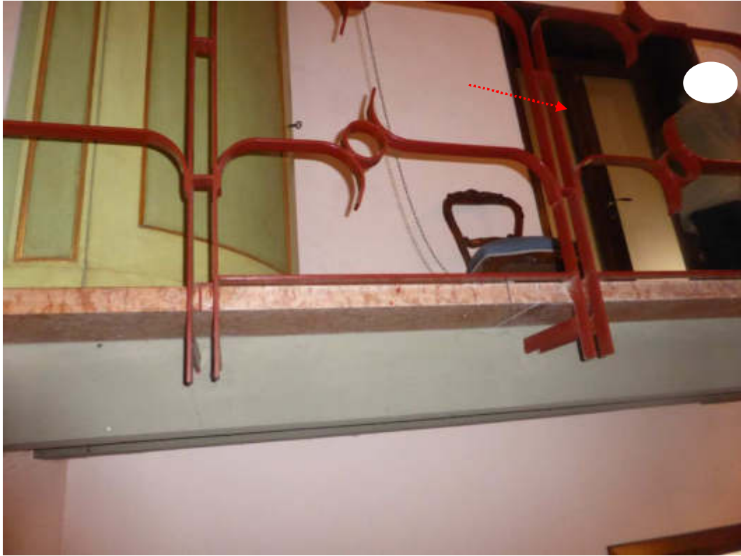
Foto 23: Dettaglio vano scala – ingresso appartamento oggetto di esecuzione (freccia rossa).
