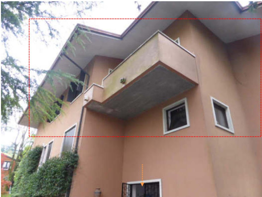
Foto 14: Vista prospettica del fabbricato immobiliare - appartamento oggetto di esecuzione (poligono rosso) con ingresso (freccia arancione).
