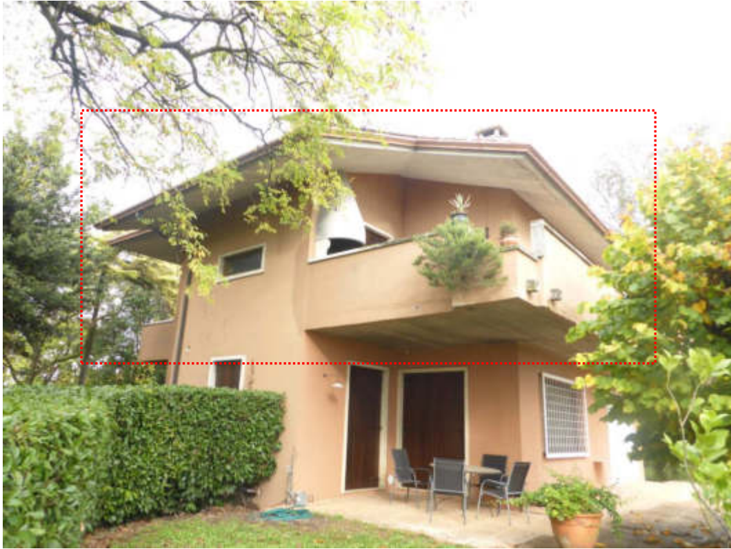
Foto 13: Vista prospettica del fabbricato immobiliare - appartamento oggetto di esecuzione (poligono rosso).
