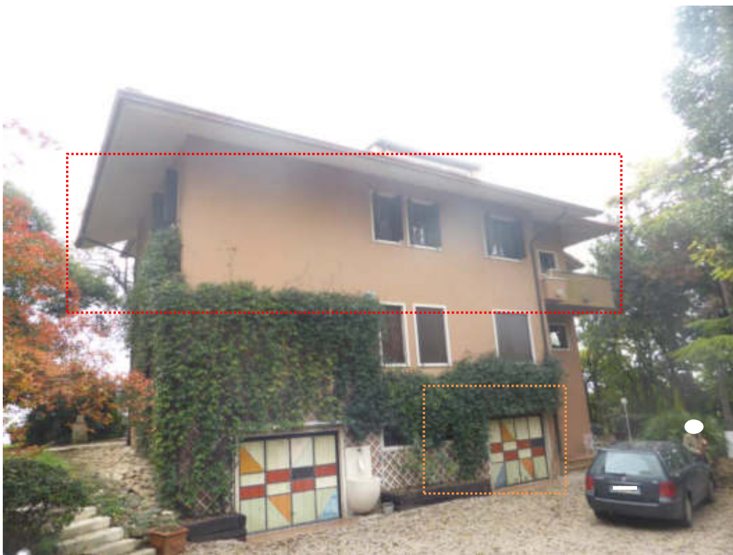
Foto 10: Vista prospettica del fabbricato immobiliare - appartamento oggetto di esecuzione (poligono rosso) ed garage (poligono arancione).
