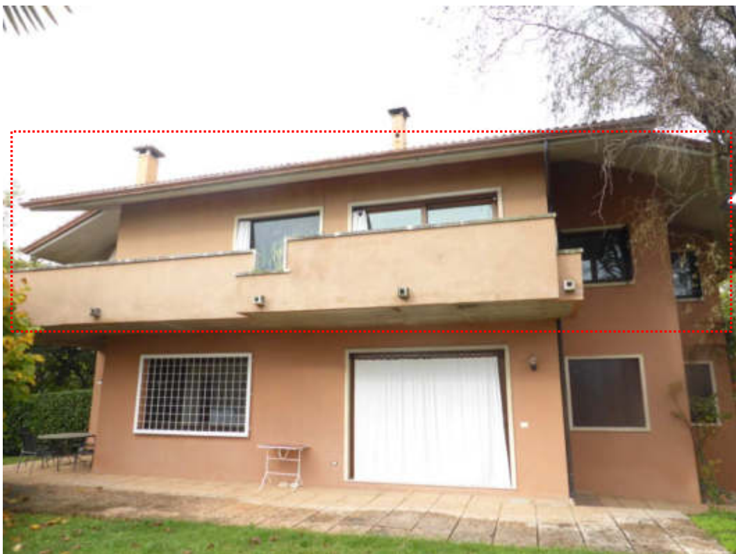
Foto 12: Vista prospettica del fabbricato immobiliare - appartamento oggetto di esecuzione (poligono rosso).
