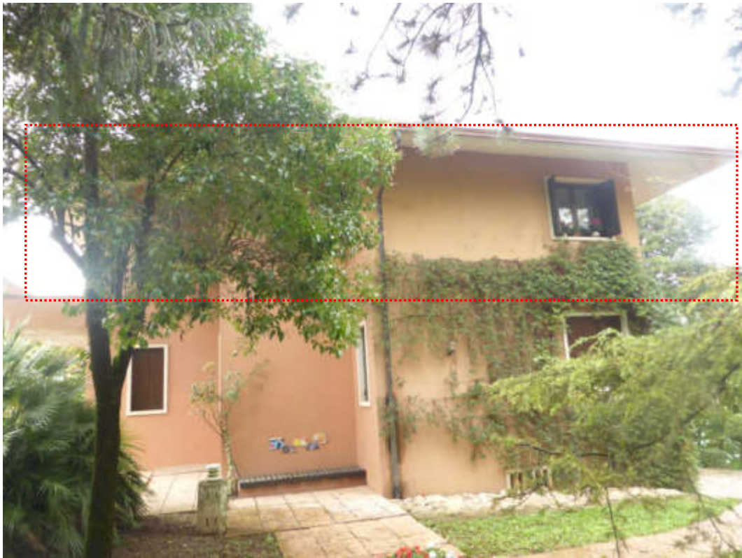
Foto 11: Vista prospettica del fabbricato immobiliare - appartamento oggetto di esecuzione (poligono rosso).
