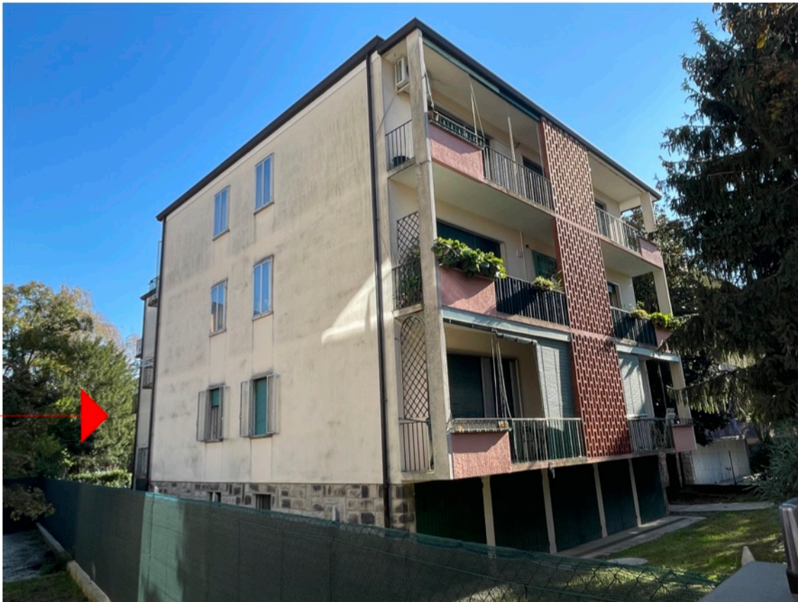
4 - Vista del fabbricato lato strada
