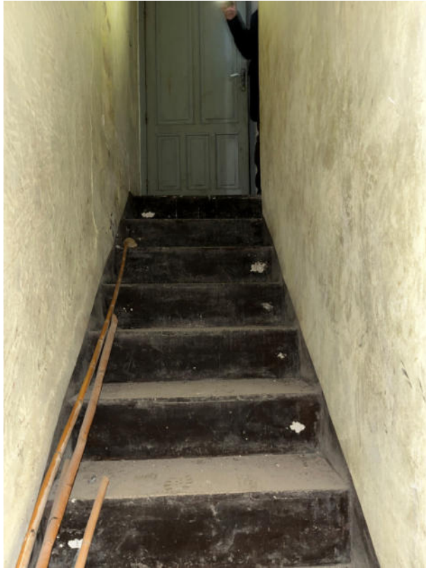
Foto 6 - scala di accesso al 1° piano
