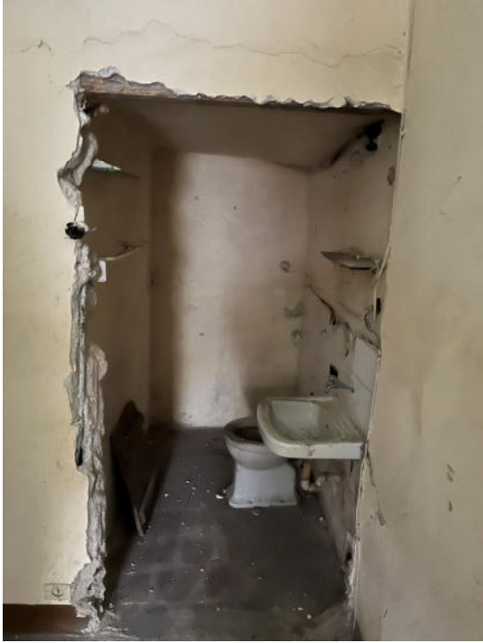
Foto 4 - piano terra - W.C
