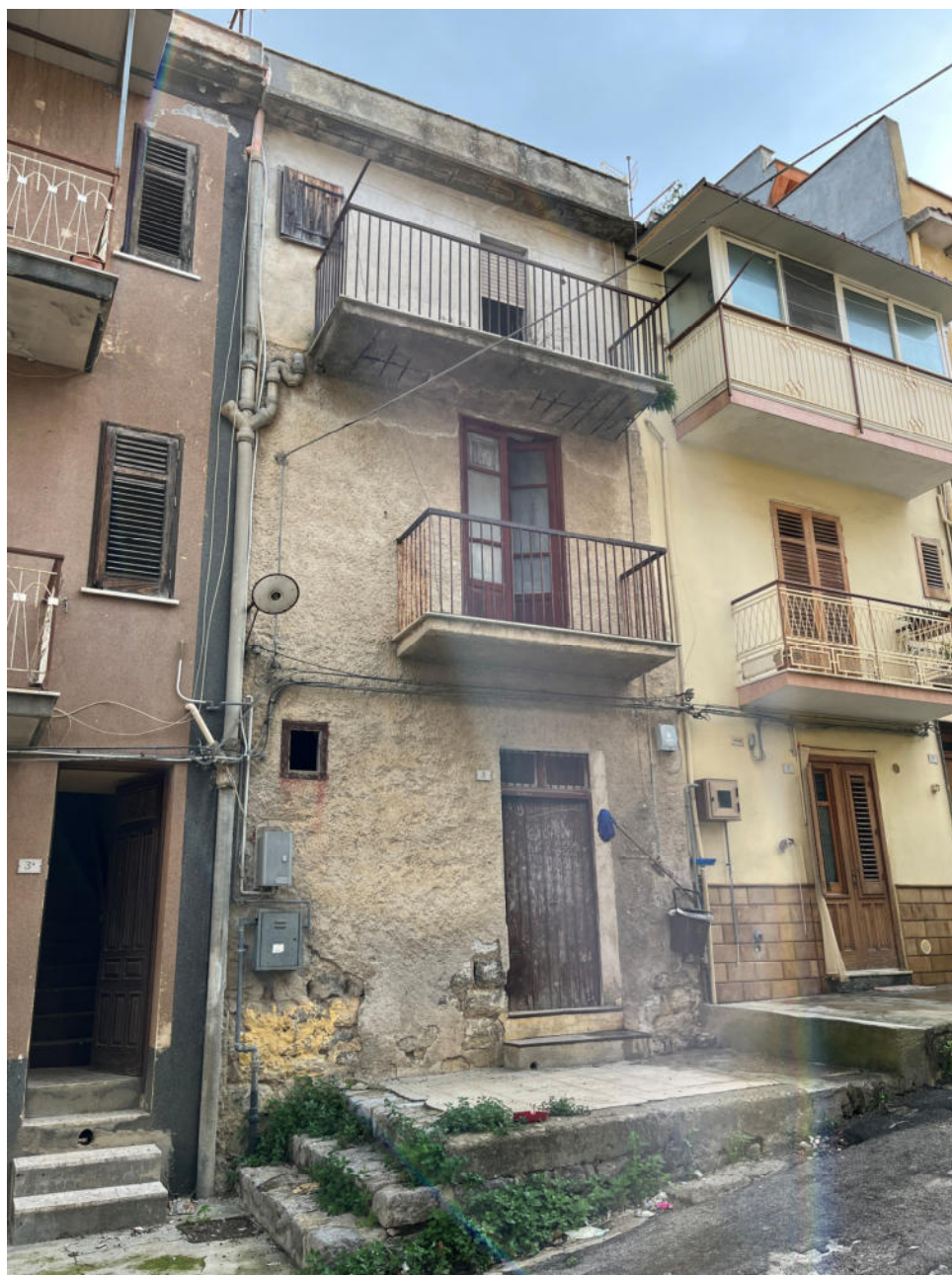
Foto 1 Prospetto principale su via Giardina 5
