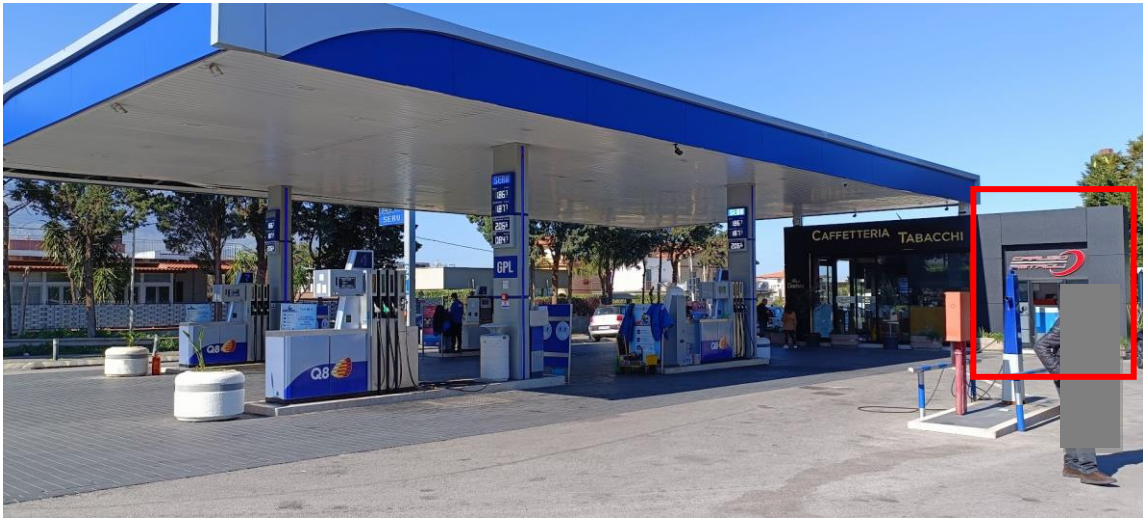
In rosso: locale tecnico adiacente il bar /tabaccheria autorizzato come pergolato e chiuso invece con infissi
