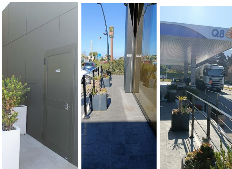
Viste delle rampe esterne e dell'ingresso ai bagni del locale commerciale sub. 3
