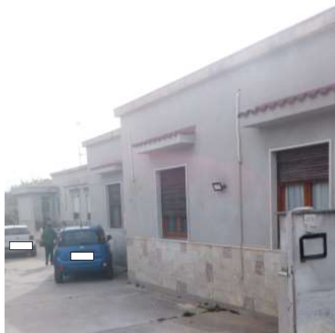
Foto 8 - Prospetto sud-est (p.lla 69)
