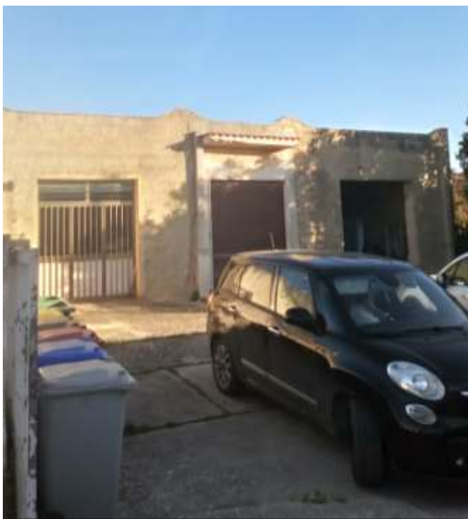
Foto 7 - Prospetto nord-ovest (p.lla 61)
