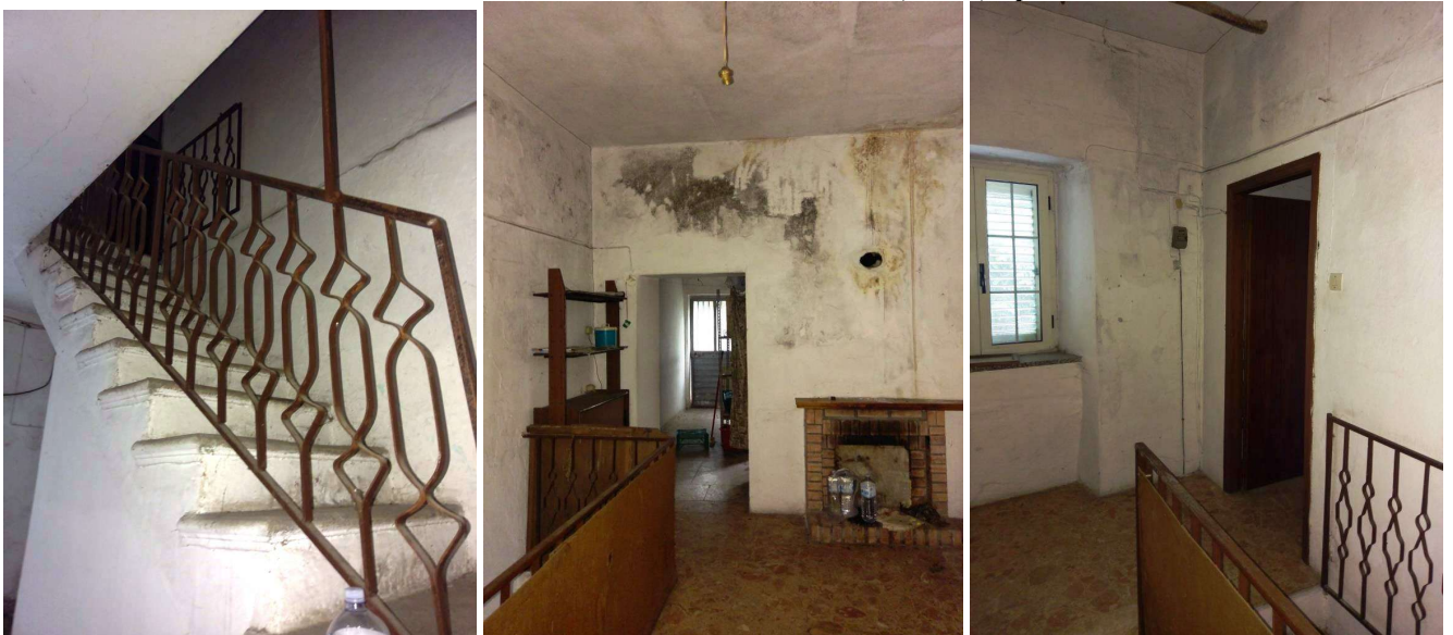
Foto 17, 18 e 19- scala interna e disimpegno al 1° piano
