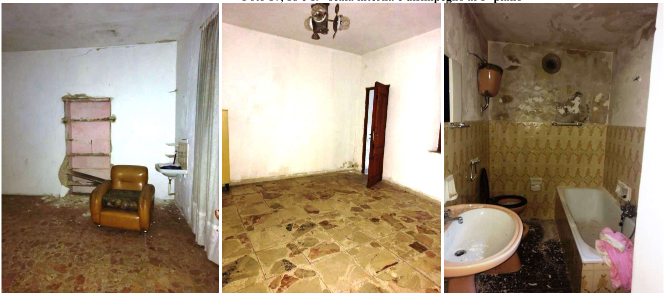
Foto 20, 21 e 22- particolare delle camere e del bagno al 1° piano
