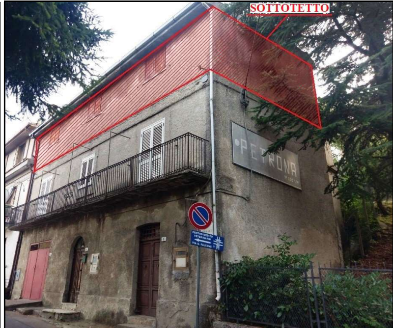
TAVOLA 2- ampliamento in elevazione del fabbricato
