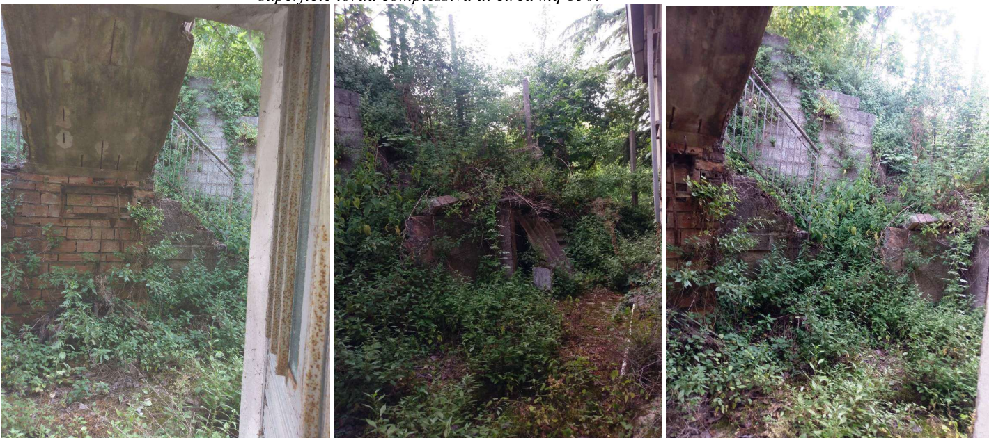
Foto 23, 24 e 25- cortile e scala d'accesso alla mansarda
