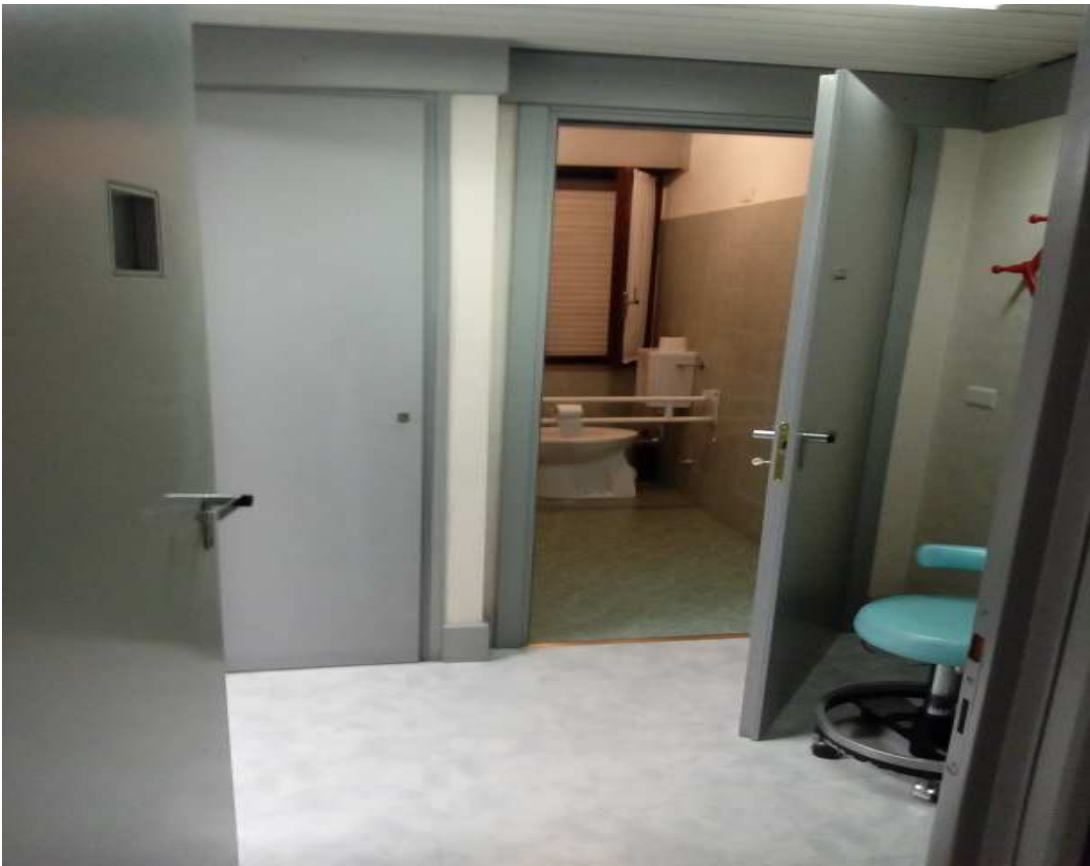
FOTO DISIMPEGNO/BAGNO DISABILI
