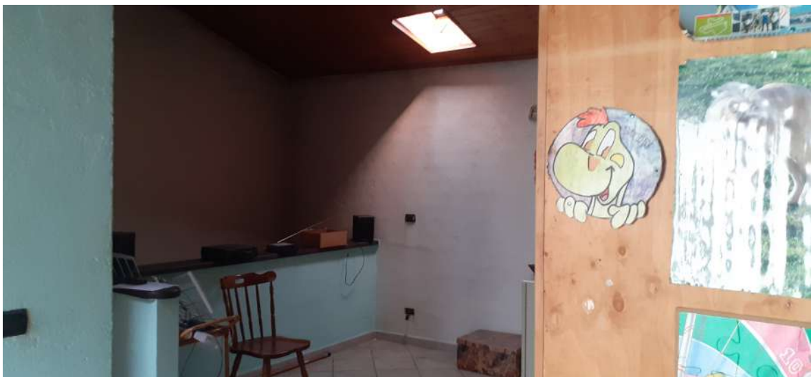
Foto n. 10: camera al piano primo e vista scala di collegamento
