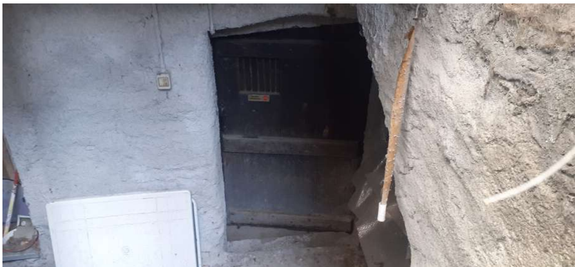
Foto n. 13: porta di accesso alla cantina al piano seminterrato
