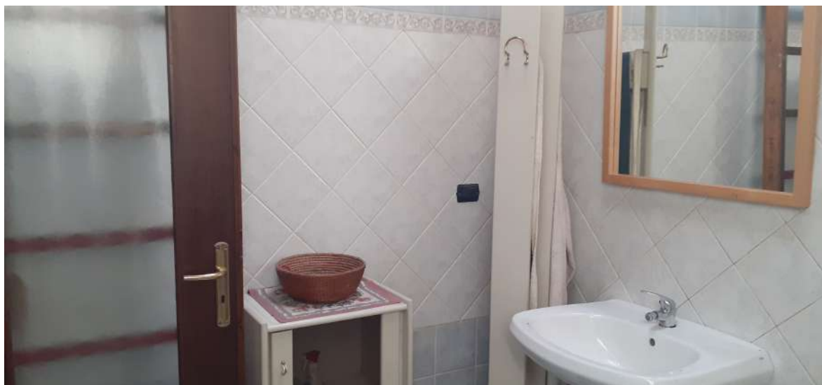
Foto n. 11: bagno al piano primo
