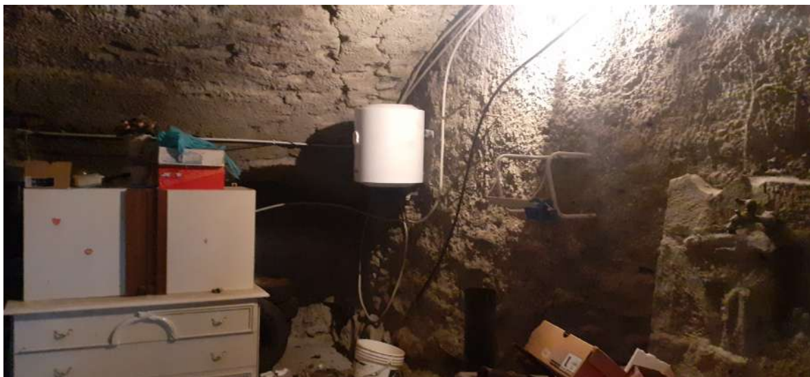
Foto n. 16: cantina al piano seminterrato
