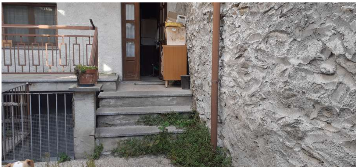
Foto n. 3: ingresso all'unità pignorata
