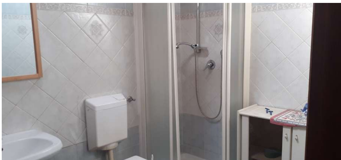
Foto n. 12: bagno al piano primo
