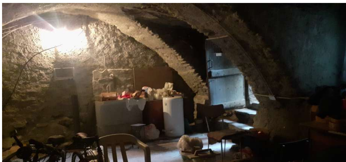
Foto n. 15: cantina al piano seminterrato
