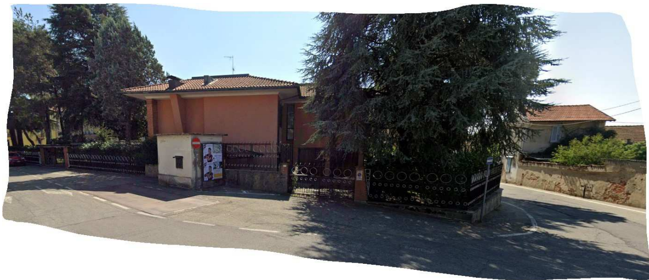
FOTO VISTA LATO OVEST
