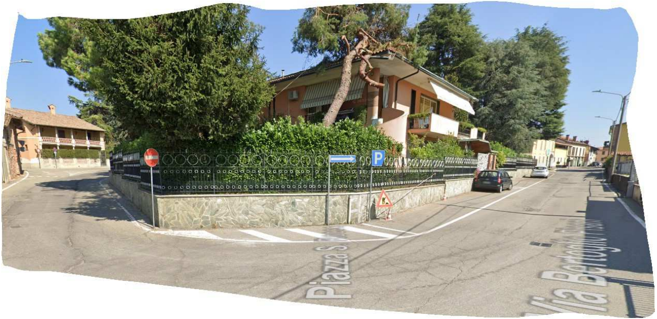
FOTO VISTA LATO SUD
