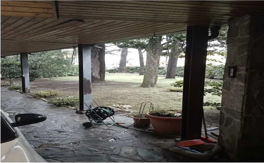
FOTO TETTOIA FRONTE ACCESSO CIVICO,1
