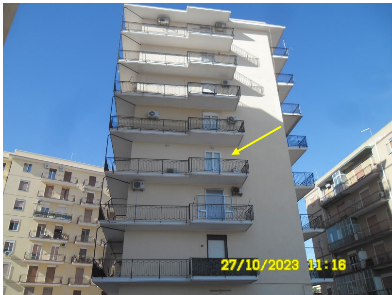
Vista prospetto laterale
