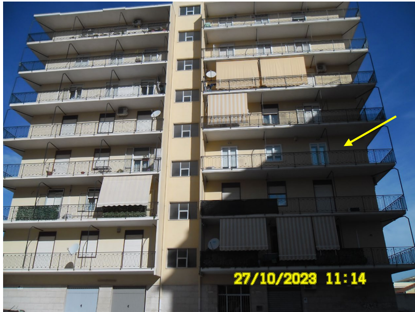
Vista prospetto frontale
