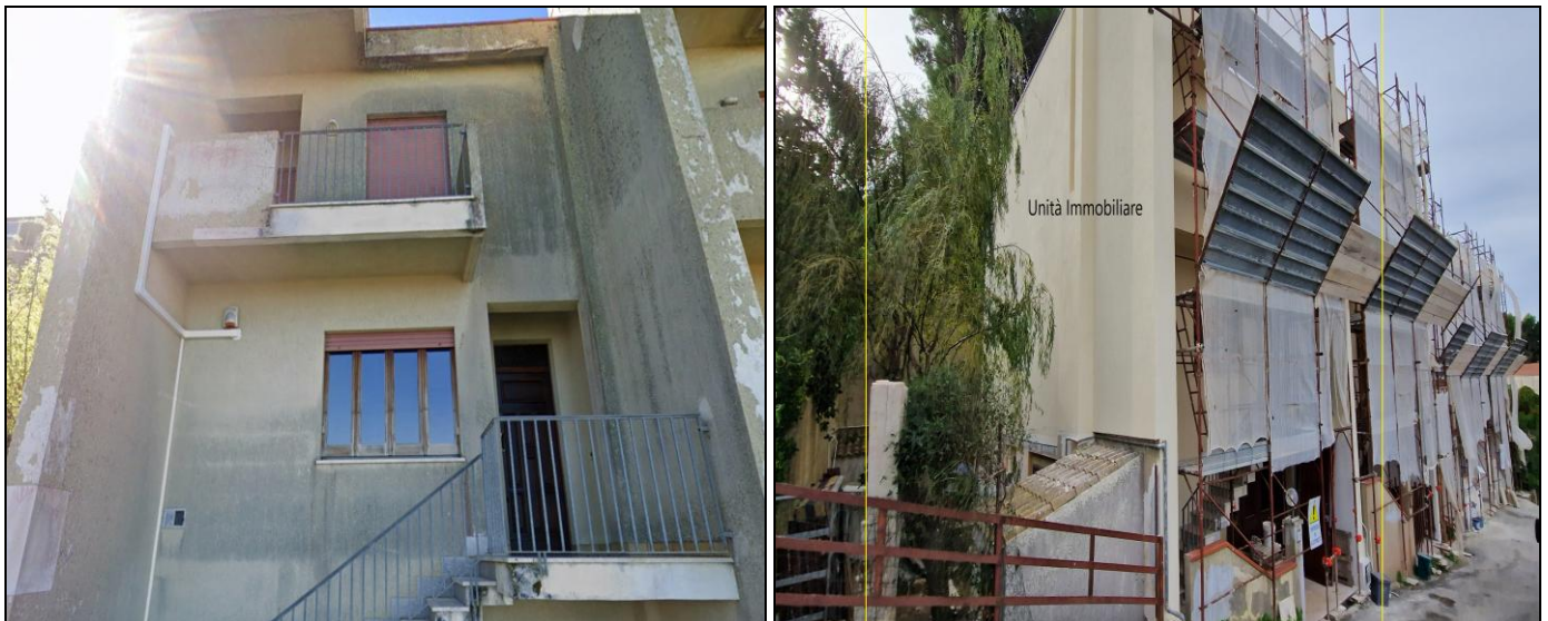
FIGURA 1 PROSPETTO ESTERNO PRIMA DEGLI INTERVENTI "CILAS" – FIGURA 2 PANORAMICA ESTERNA IN CORSO D'OPERA
