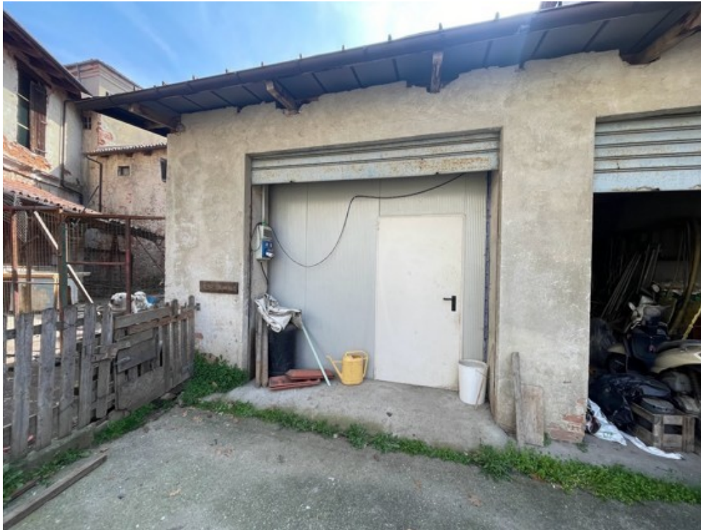
Fotografia A.51 - FOTO RIMESSA PIANO TERRA (SUB. 14 - LOTTO 1)
