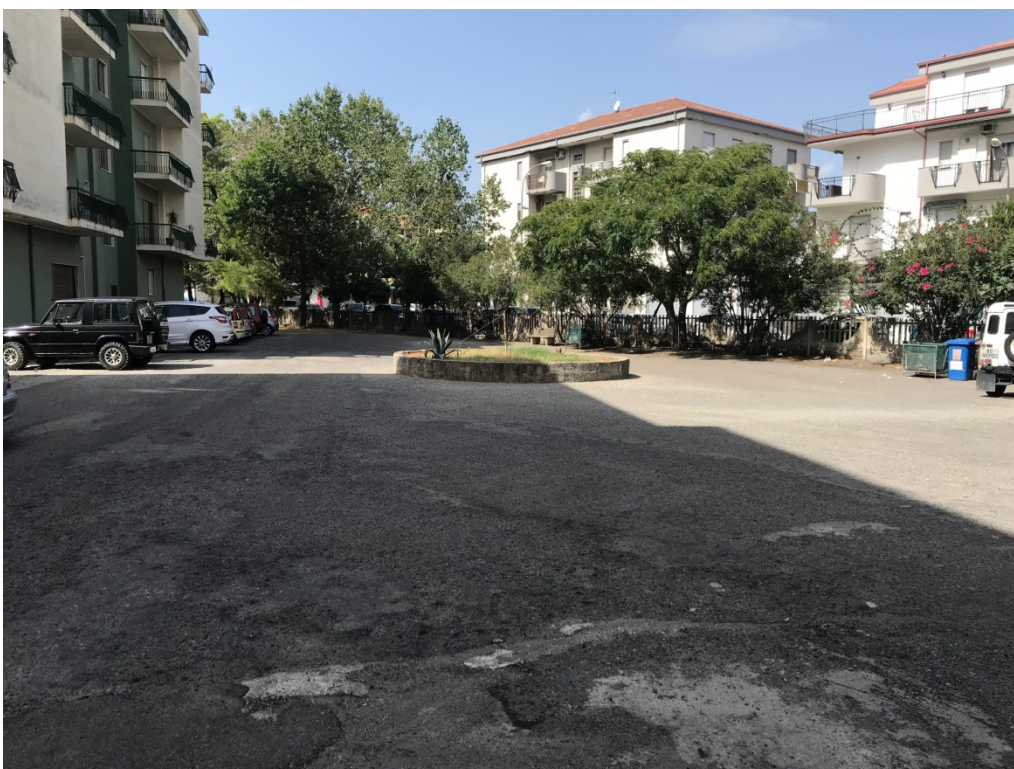
2- Cortile interno comune
