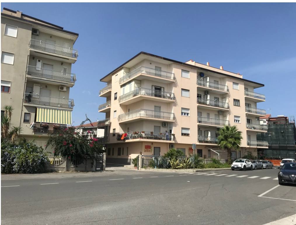
1- Vista del fabbricato
