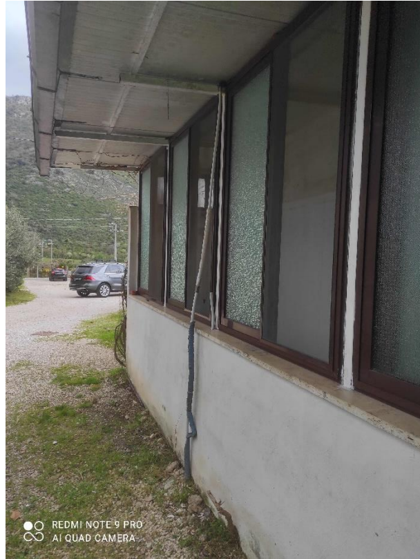
Foto vista esterna laterale dx
