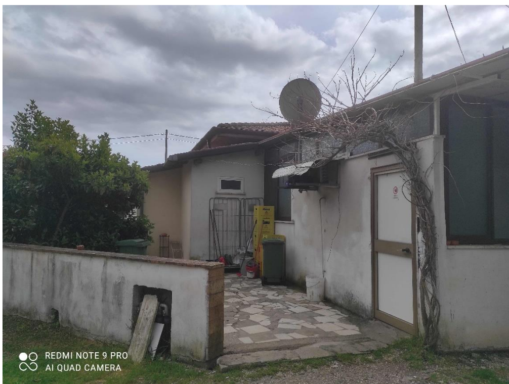
Foto vista esterna laterale sx
