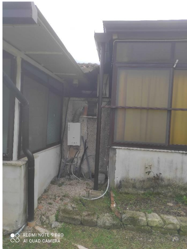
Foto vista esterna laterale dx (unione strutture)
