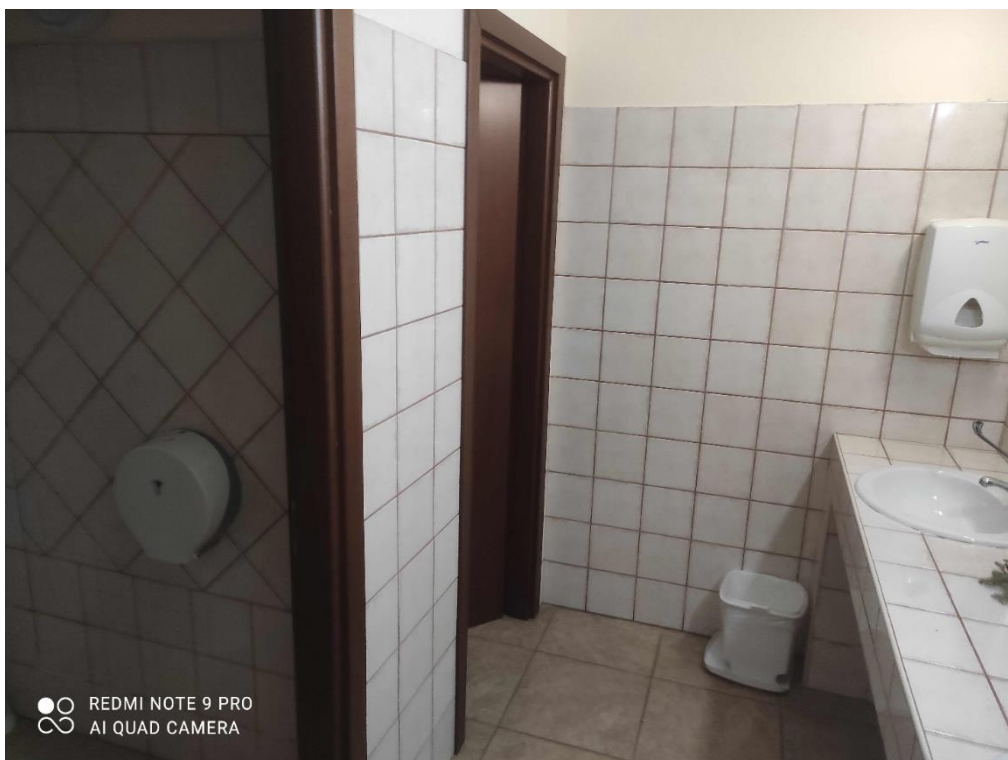
Foto antibagno WC uomini
