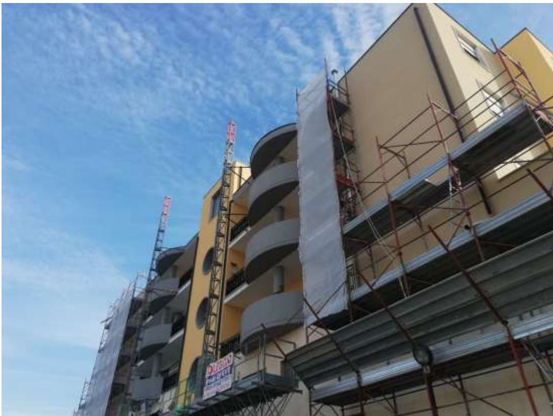
STATO DEL CONDOMINIO IN FASE DI PROCEDURA FALLIMENTARE – LAVORI IN FASE DI CONCLUSIONE
