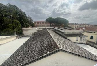
Nella relazione si riporta poi che le analisi svolte sul campione prelevato dai pannelli della copertura in esame hanno infatti confermato la presenza di "fibre di amianto Crisotilo" e "fibre di amianto Crocidotile".
