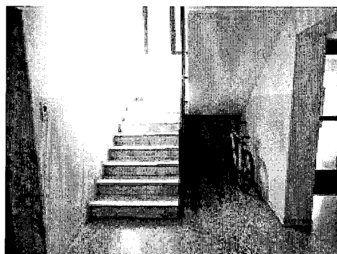
Vista ingresso alla palazzina piano interrato
