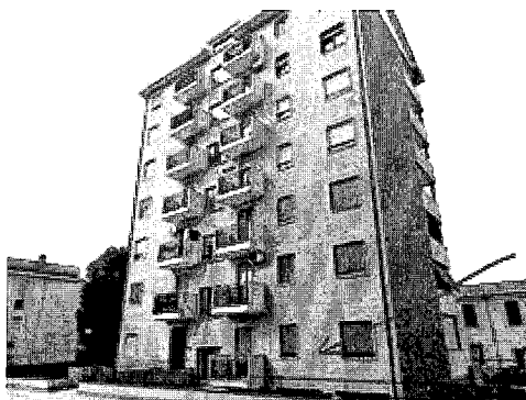
Vista appartamento dal cortile interno
