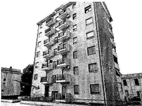
Vista appartamento dal cortile interno
