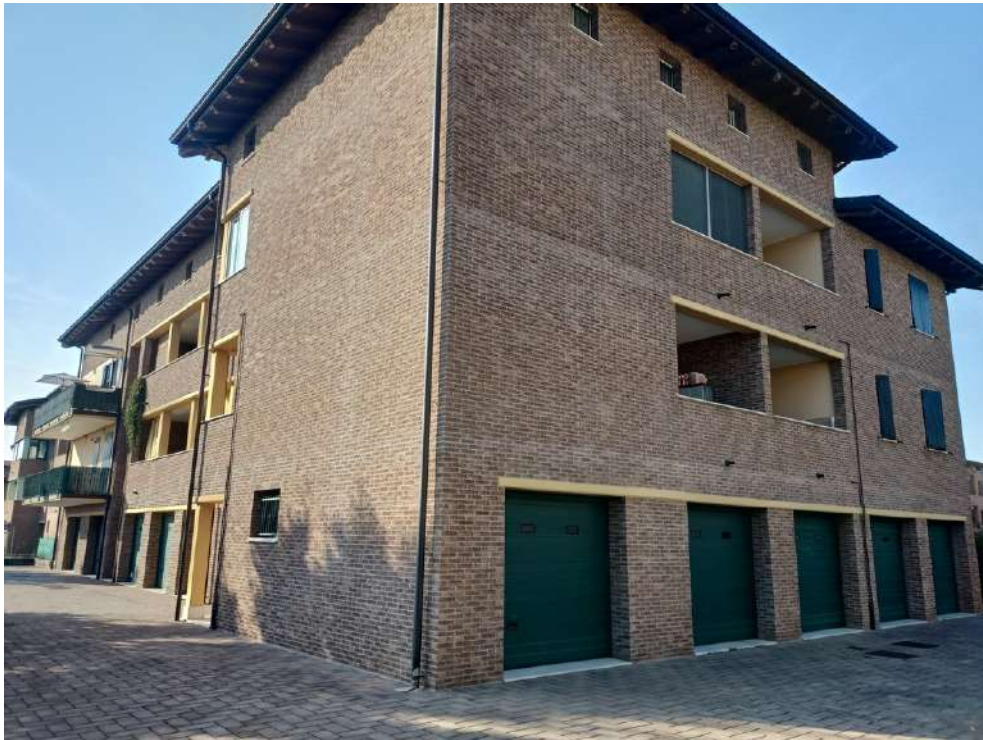
Foto n. 2 – Fronte Sud Est del fabbricato condominiale di cui al mappale 696
