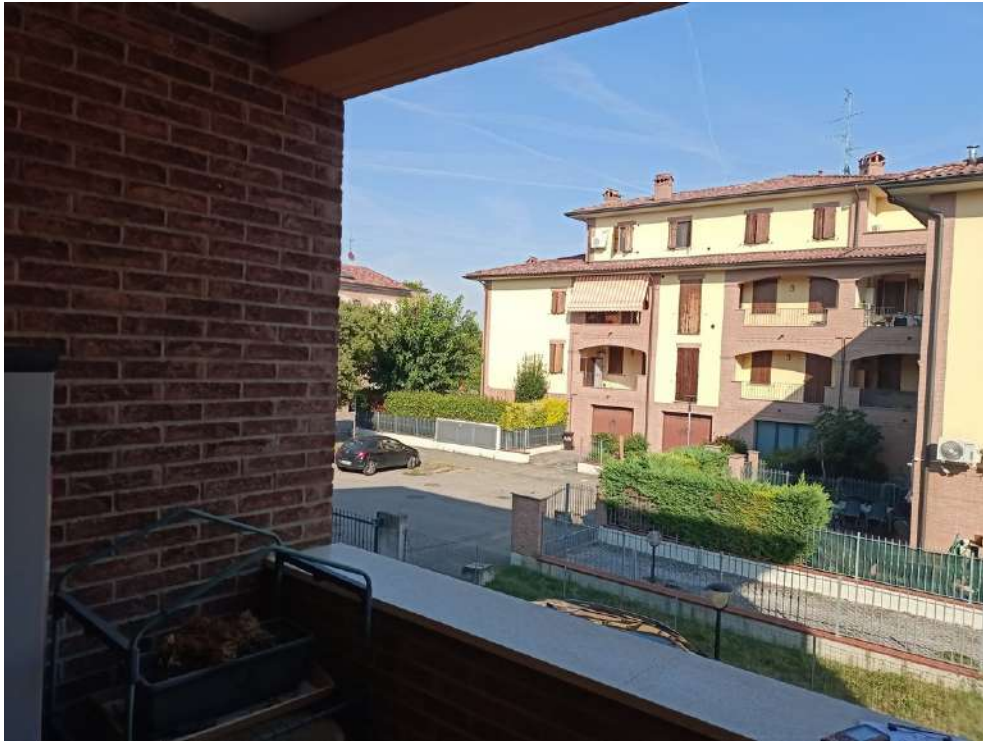
Foto n. 10 – Appartamento – Piano primo – Loggia
