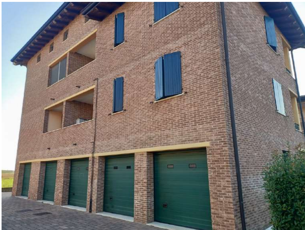
Foto n. 3 – Fronte Nord Est del fabbricato condominiale di cui al mappale 696
