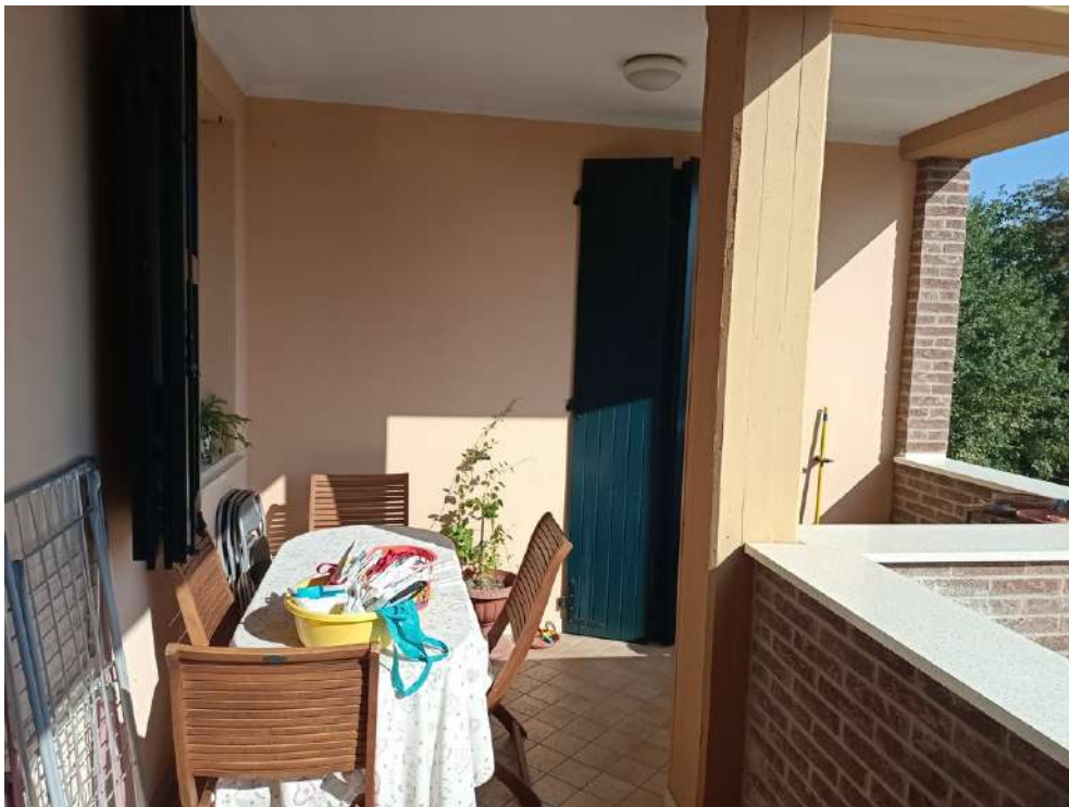
Foto n. 9 – Appartamento – Piano primo – Loggia
